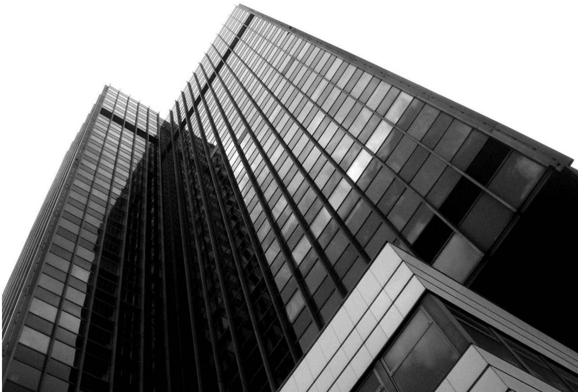
Abb. 146 Bei sehr hohen Gebäuden lassen sich stürzende Linien oft nicht vermeiden. Hält man die Kamera steil nach oben, wird der Effekt maximal, ist aber dann von künstlerisch hohem Interesse.
