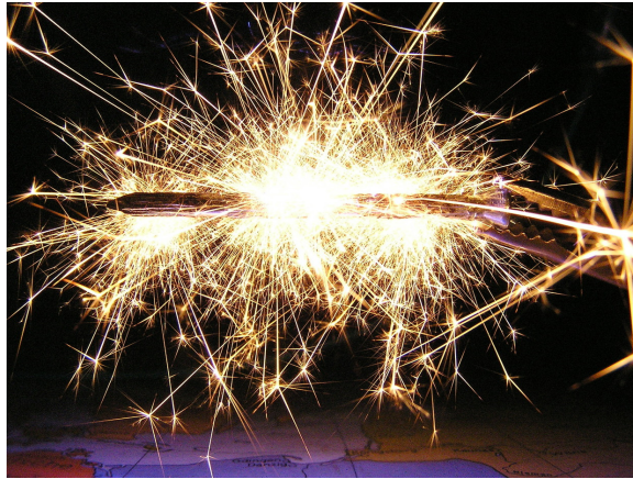
Abb. 93 Mehrere Kurzschlüsse - 16 Sekunden Belichtungszeit.
