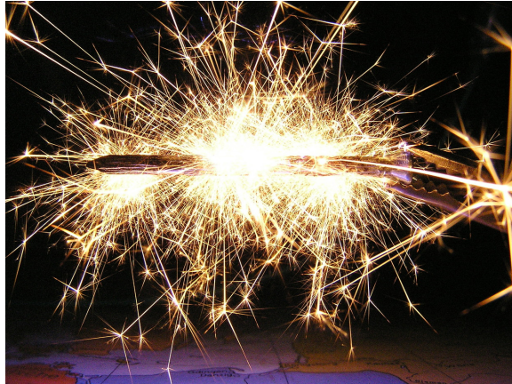
Abb. 93 Mehrere Kurzschlüsse - 16 Sekunden Belichtungszeit.
