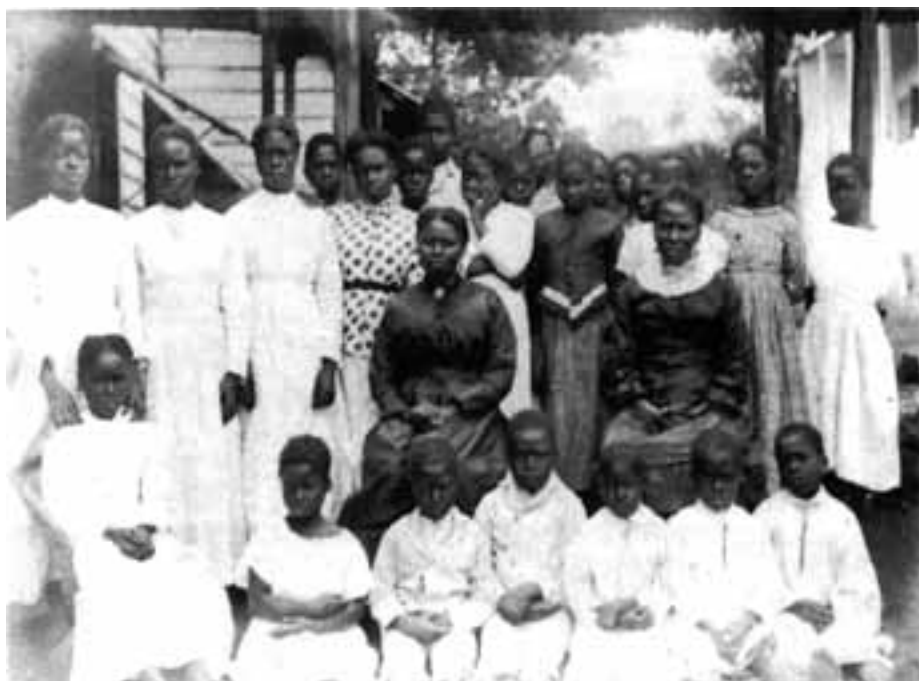
FIGURA 3.4 Escola da vila Charlotte, Serra Leoa, cerca de 1885. [Fonte: A.T. Porter, Creoleland , 1963, Oxford University Press, Oxford. © Domínio público, com autorização da Foreign and Commonwealth Office Library .]
