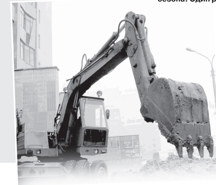
Сегодня в разных районах города ведутся активные работы на инженерных коммуникациях.
