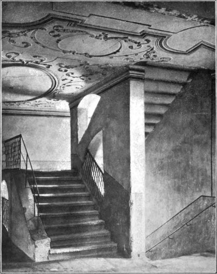
Treppenaufgang im nördlichen Saale der Pilzläuben in Görlitz.
