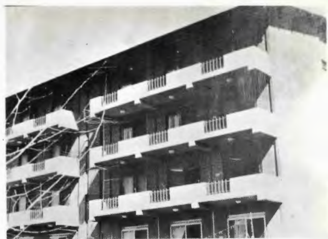
بالا و سمت چپ: نمونه قسمتهائی از ساختمانهای مجهز مسکونی درجه داران و سایر کارکنان یکی از یگانهای نیروی هوایی شاهنشاهی که بوسیله مهندسی این نیرو ساخته و آماده بهره برداری شده اند.
