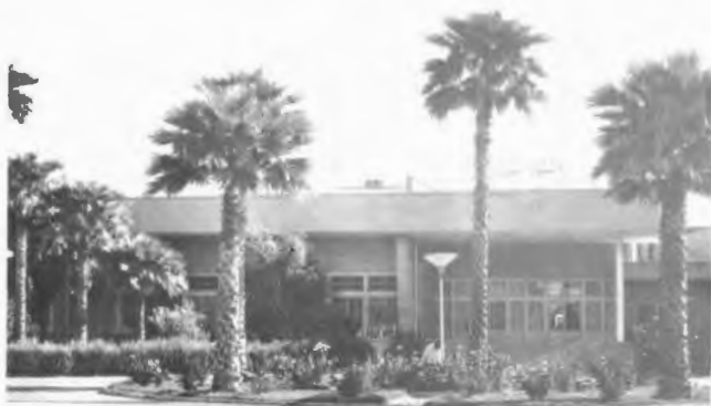
نمای خارجی قسمتی از باشگاه افسران پایگاه هوایی وحدتی
