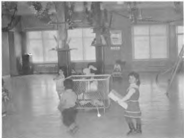
منظره‌ای از داخل مهد کودک پایگاه هوایی وحدتی
