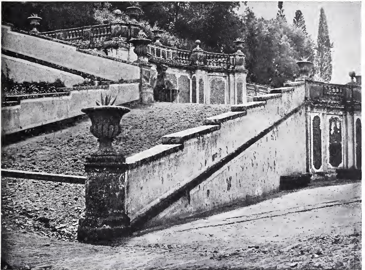
Villa Conti Tarlonoia, Frascati, Rampenanlage
