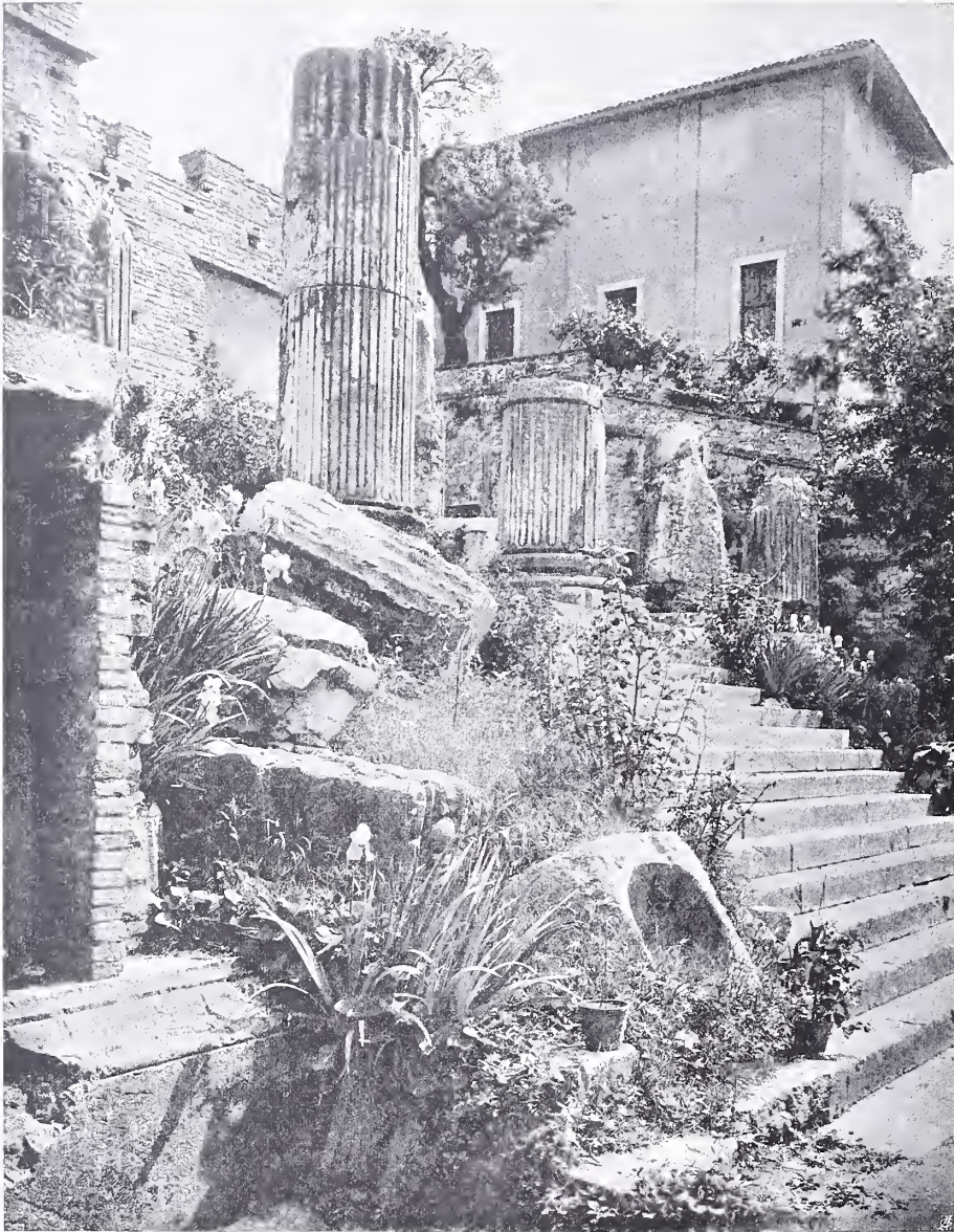
Freitreppe des römischen Tempels zu Brescia
