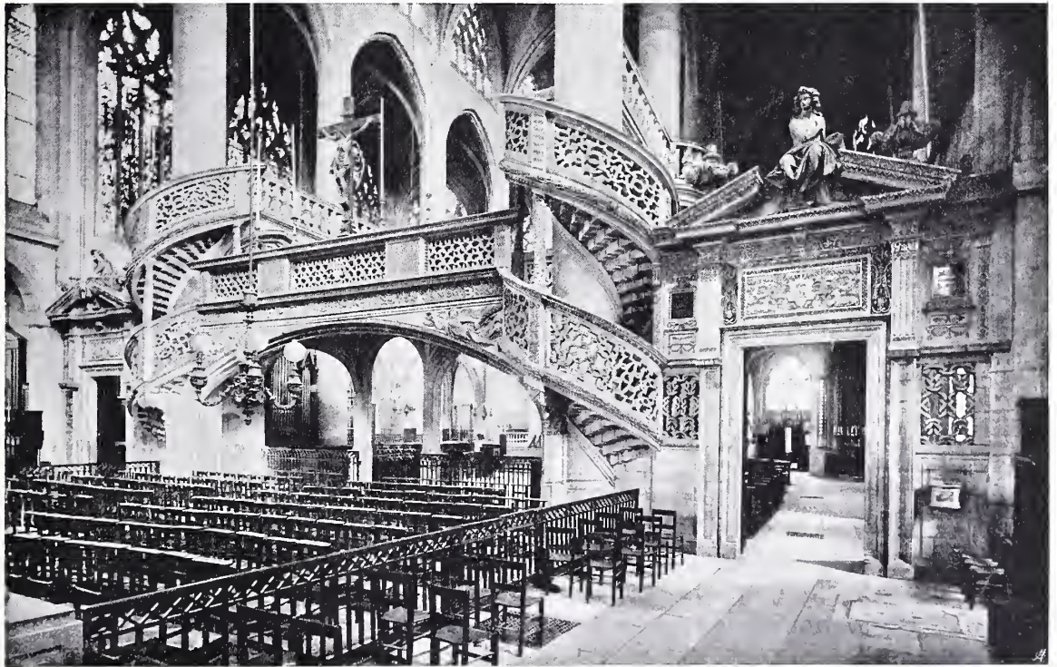
Treppenanlage in St. Etienne du Mont (Paris)
