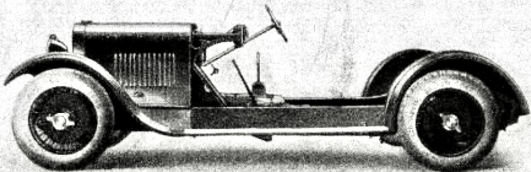
Chassis, Seitenansicht mit Haube und Kotflügel.
