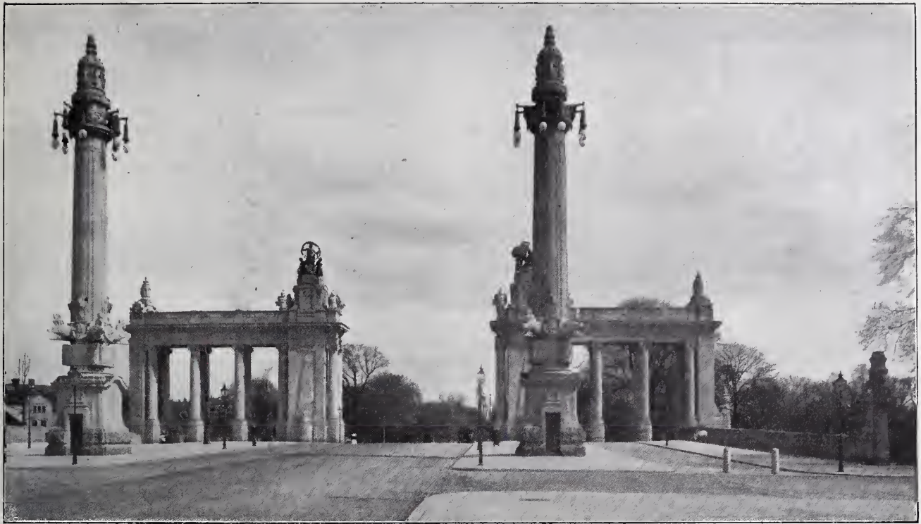
Der Neubau der Charlottenburger Brücke. Ansicht des Brückenaufbaues von Charlottenburg her gegen den Tiergarten.
