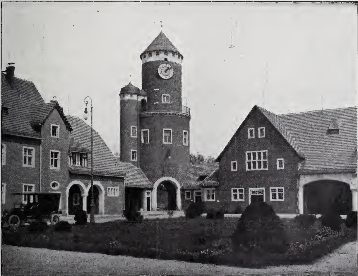
Stallhof mit Blick auf das Wohn- und Wirtschaftshaus, den Wasserturm und den Gaststall. Schloss Brynnek-Siemianowitz des Grafen Hugo Henckel von Donnersmarck in Oberschlesien. Architekt: Kgl. Baurat Karl Grosser in Breslau.
