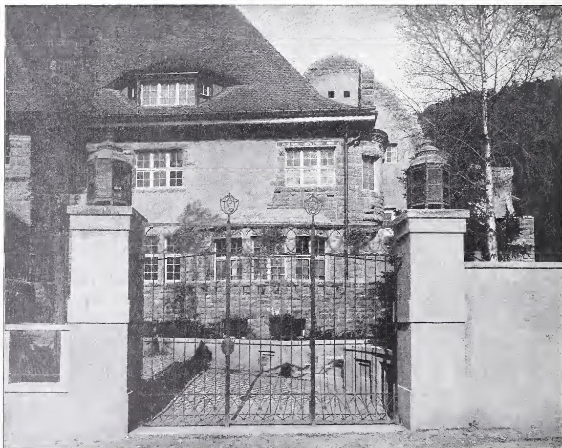
Ansicht der Einfahrt mit rechtem Gebäudeteil (Speisezimmer).
