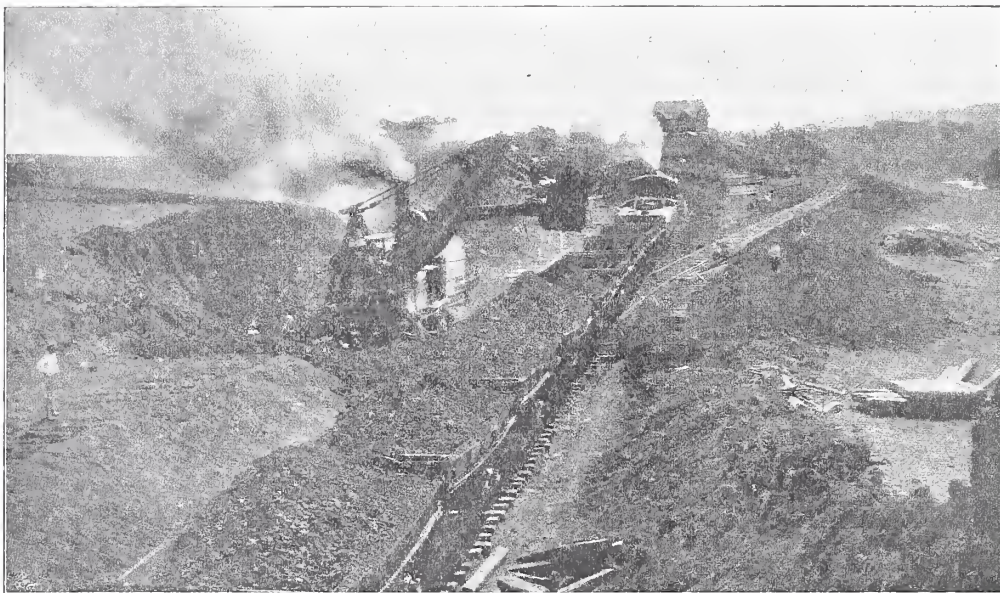
Abbildung 4. Trocken-Aushub der Schleusen-Baugrube bei Gatun, Januar 1907.
