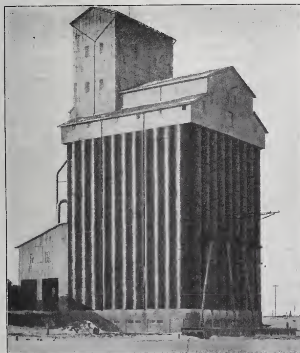
Abbildung 9. Der Silo im Fort Williams vor dem Einsturz.
