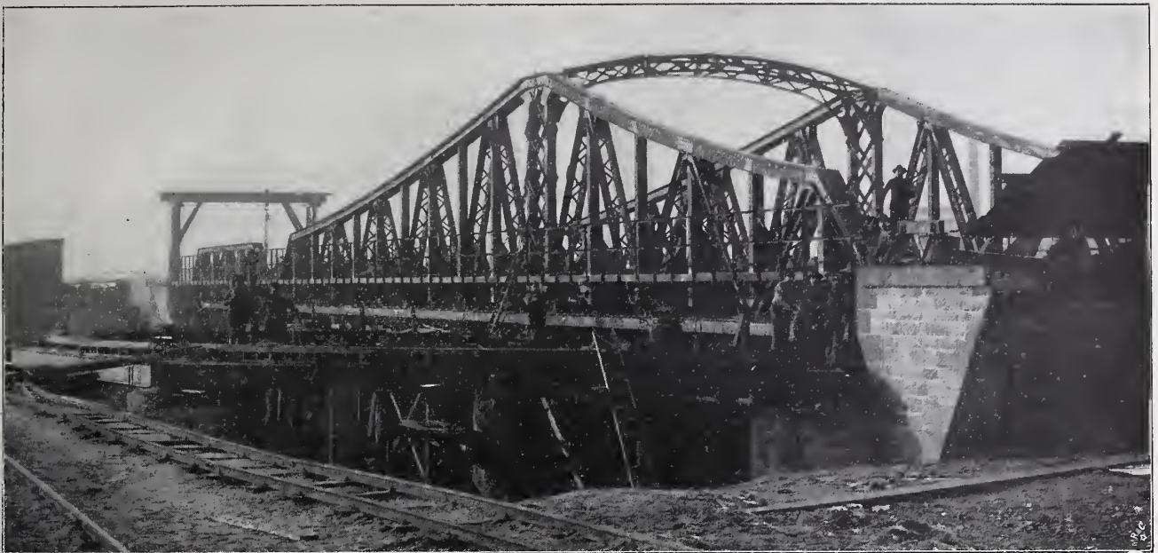
Abbildung 9. Doppelgleisige Eisenbahn-Drehbrücke im neuen Ruhrorter Hafen über den Durchstich zwischen Kaiserhafen und Hafenskanal.
