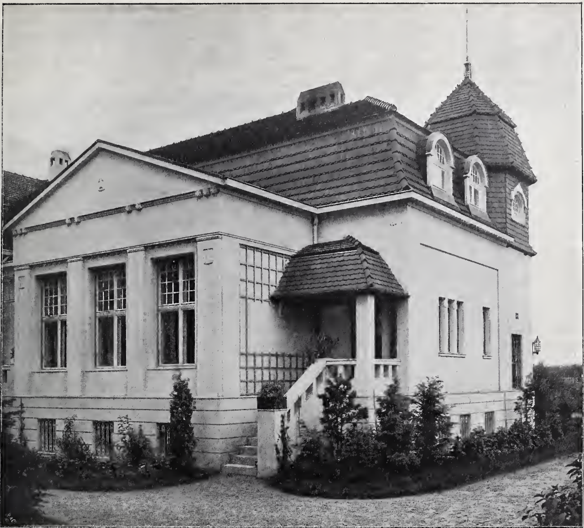
Ansicht eines Teiles der Rückfassade und der einen Seitenfassade.
