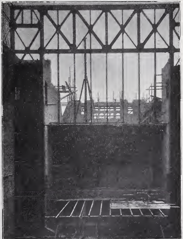
Abbildung 11. Hinterwand des Bühnenhauses in der Ausführung. Eisen-Konstruktionen im neuen Stadttheater in Kiel
