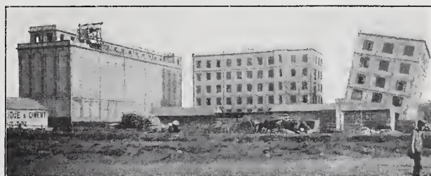
Abbildung 7. Silospeicher in Tunis, wieder geradegestellt. Mehlspeicher stark geneigt.
