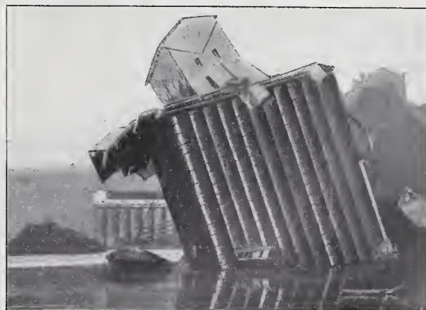
Abbildung 10. Der Silo nach dem Kaministiqua-Fluß eingestürzt.
