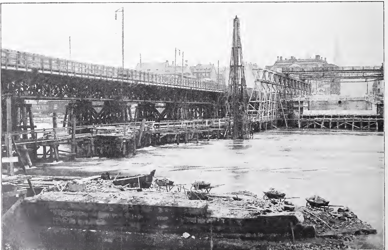
Abbildungen 4 und 5. Seitenansichten der eigentlichen Strombrücke mit den eisernen Ueberbauten. (Aufnahmen April 1908.)
