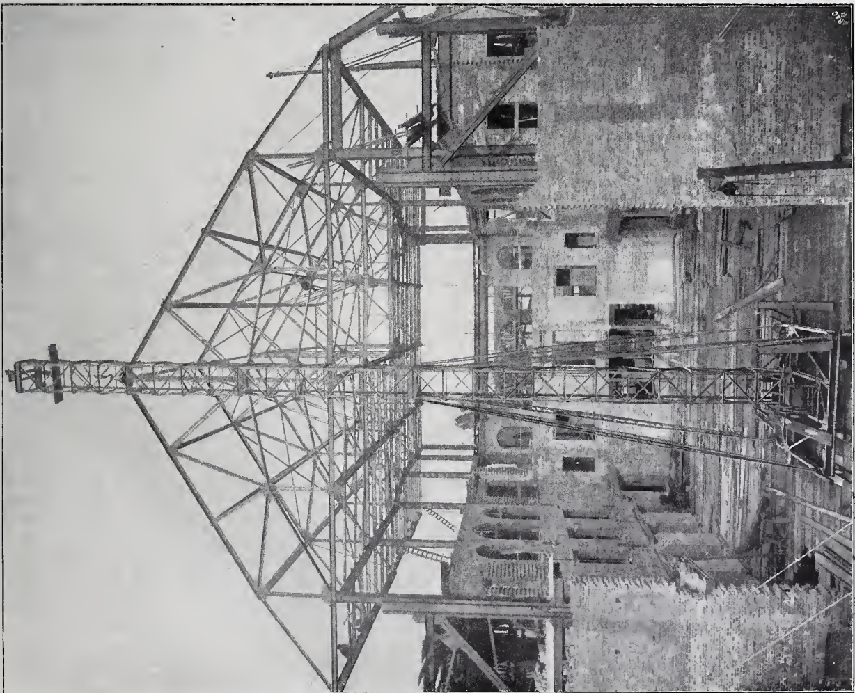
Abbildung 6. Blick in 2 das Zuschauerhaus während der Aufstellung der Dachkonstruktion. Eisen-Konstruktionen im neuen Stadttheater in Kiel.
