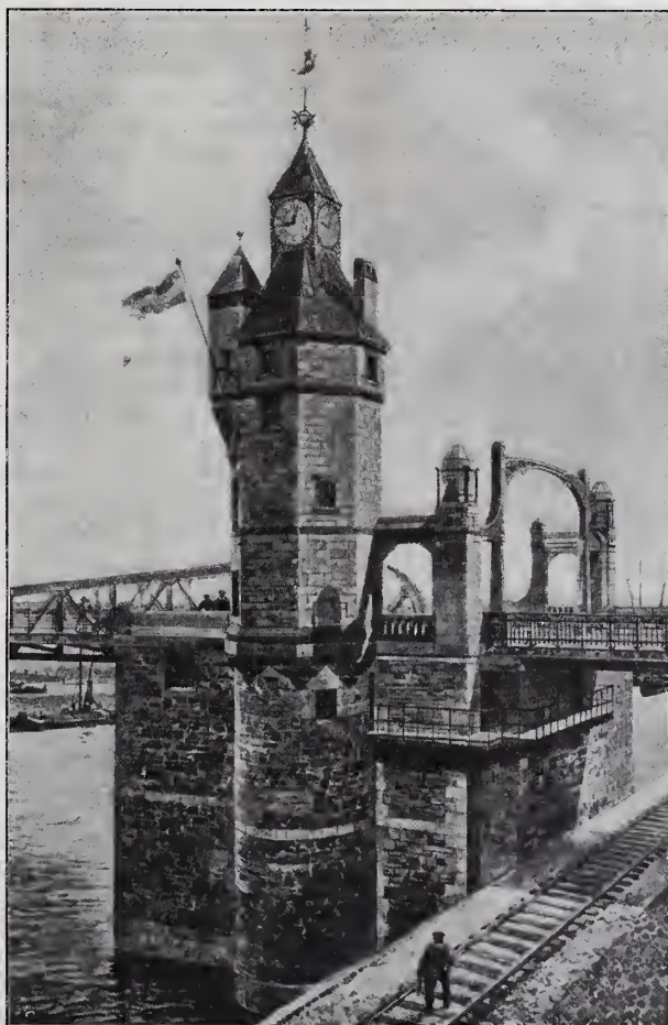
Abbildg. 4. Brückenpfeiler der Klappbrücke über den Hafkanal.
