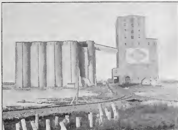
Abbildung 3. Zusammenbruch von 2 Zellen des Silos in Duluth im Jahre 1903.
