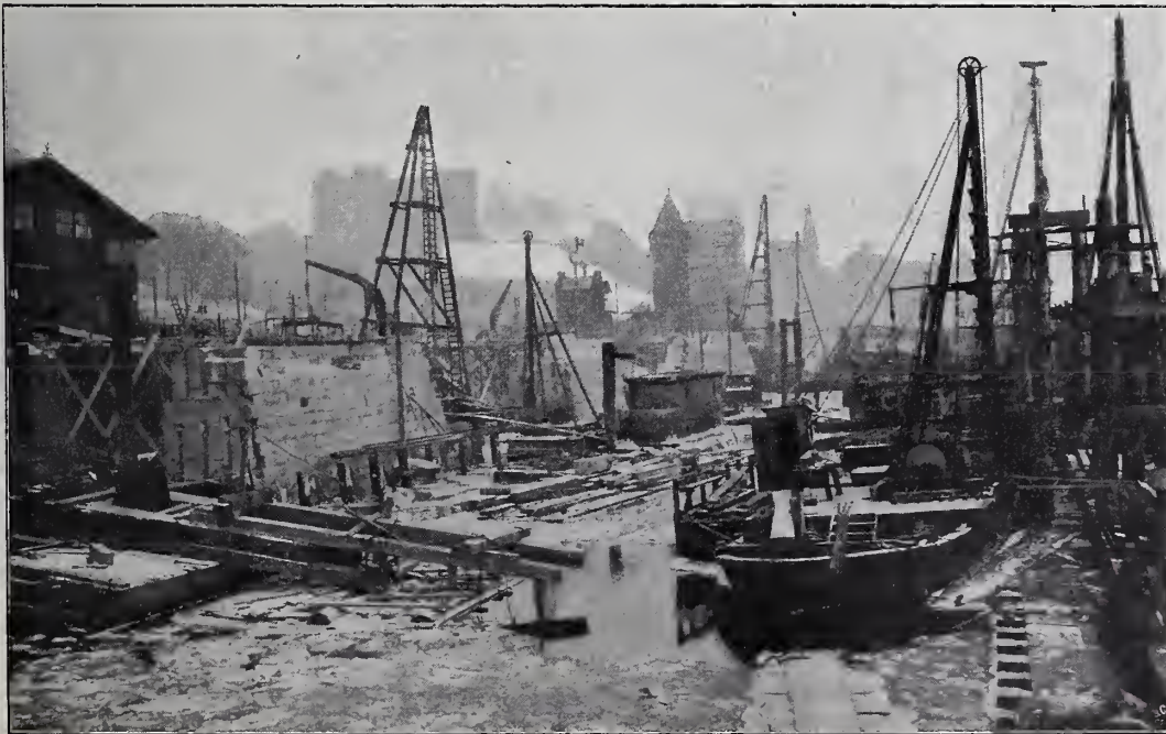
Abb. 14 (oben). Landungsbühne, westlicher Teil. April 1908. — Abb. 15 (Mitte). Montage der Landungsbühne im Kohlenschiffhafen. April 1908. — Abb. 8. Oestl. Teilstrecken der Ufermauer nach Abbruch der alten Brücke. Dez. 1907.
