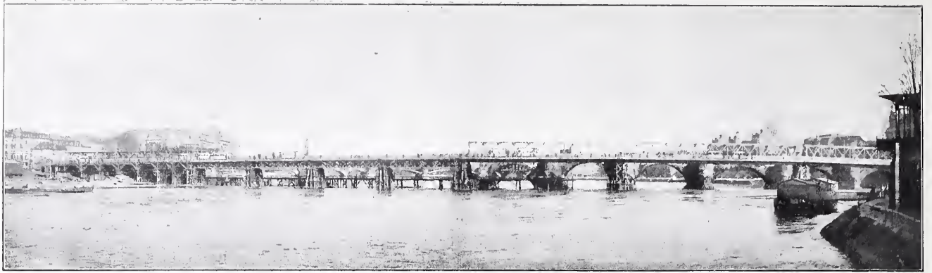
Abbildung 3. Ansicht der fertigen Hilfsbrücke vom Unterstrom gesehen, 27. März 1908. (Alte Brücke im Abbruch.)
