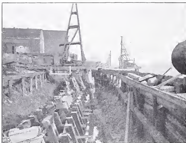
Abbildung 9. Abruch der alten Brückenpfeiler-Gründung.
