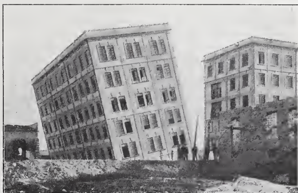
Abbildung 5. Mehlspeicher in Tunis in gefährlicher Schiefstellung.
