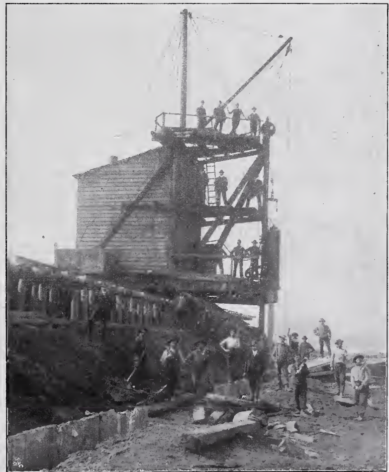
Abbildungen 7 und 8. Rammern für die Herstellung des Bohlwerkes in Eisenbeton (Ausführung Möbus) mit Aufzugskran.
