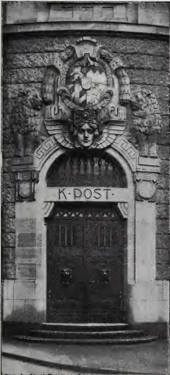
Eingang zur Schalterhalle an der Adlerstraße.
