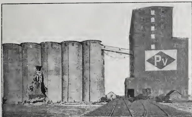
Abbildung 2. 1. Einsturz einer Zelle des Silos in Duluth i. J. 1900.
