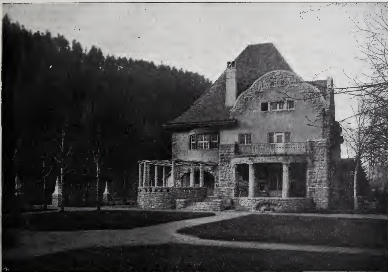
Ansicht der Stirnseite mit vorgelagerter Veranda und Terrasse.
