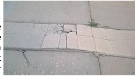
In der Regel dehnen sich die Stoffe bei steigender Temperatur aus. Das kann bei technischen Konstruktionen zu Schaden führen, wie man im Bild sehen kann. In diesen Fällen hat man die Konstruktion bei einer niedrigeren Temperatur ohne Lücken
