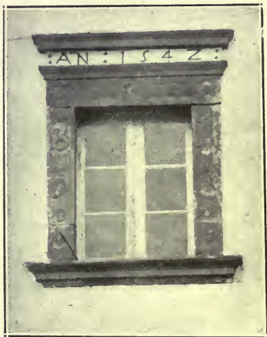
Ventanal de piedra en su forma primitiva, con la fecha en que se construyó el edificio
