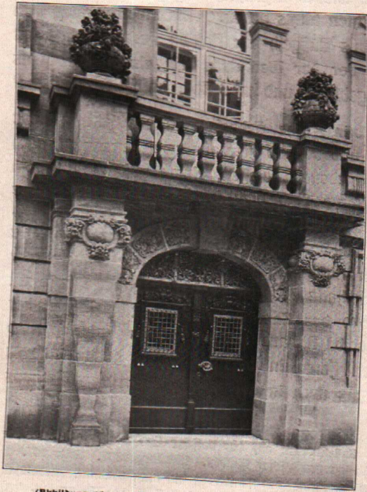
(Abbildung 13.) Eingangstür des neuen Rathauses an der Fünffensterstraße.
