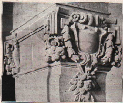
(Abbildung 38.) Kapitäl eines Pfeilers aus der Haupthalle.
