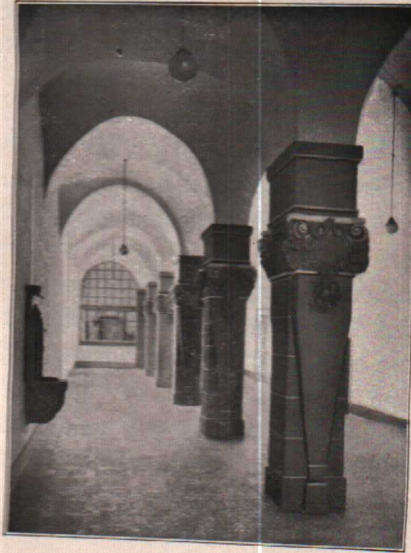
(Abbildung 21.) Seitenhalle im Hauptgeschloß des neuen Rathauses.
