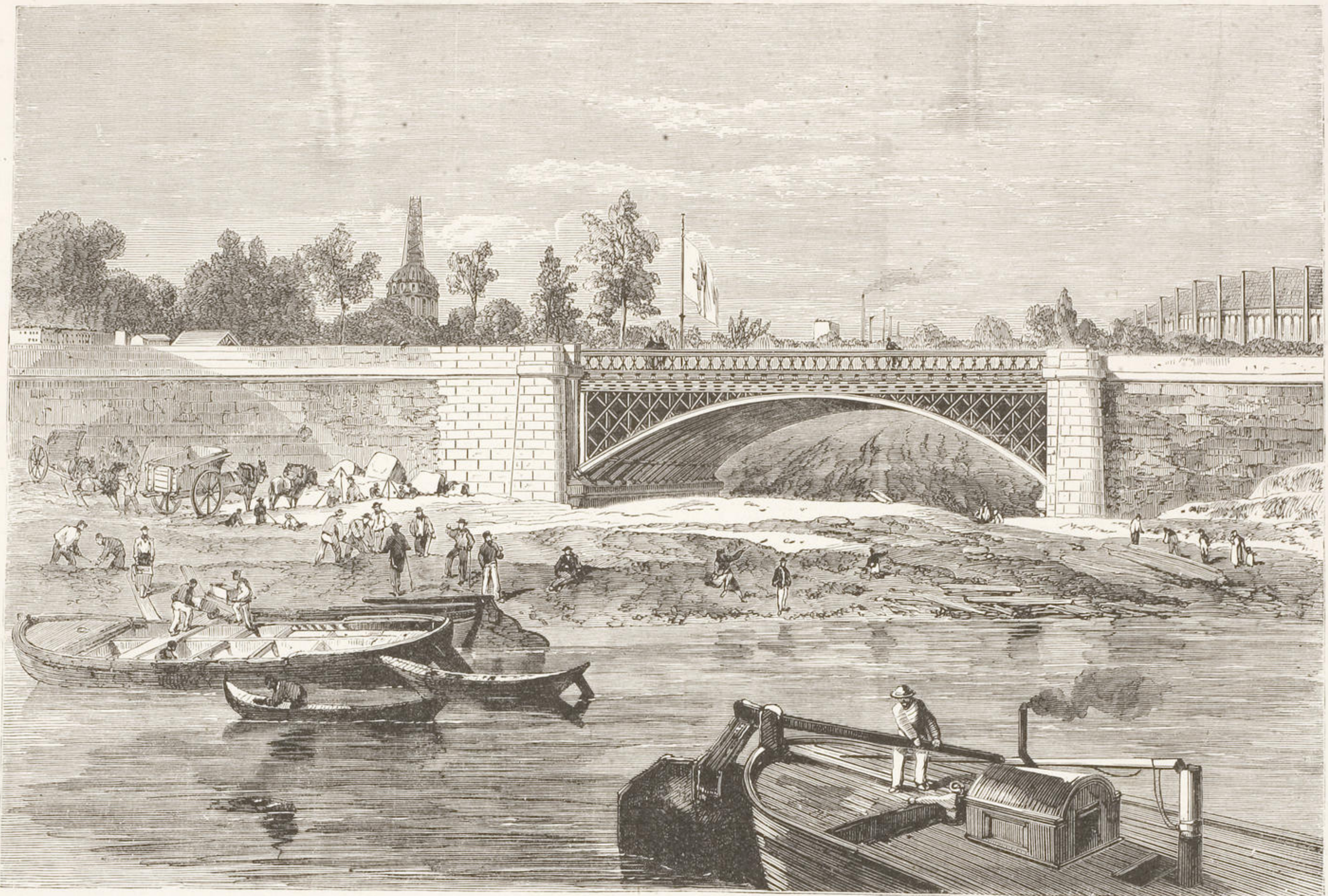
MONTAGE DU PONT D'ACIER SUR LE QUAI D'ORSAY
