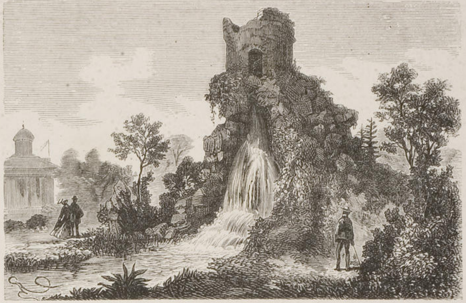
Ruine artificielle. — Château-d'eau
