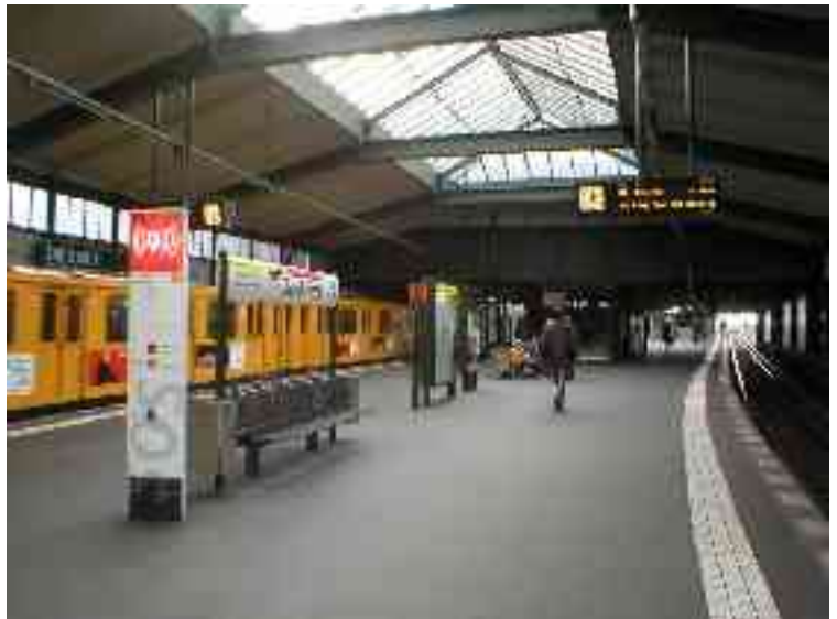
Abbildung 19 - Gleisdreieck – Bahnsteig der U2 (unterer Bahnsteig)
