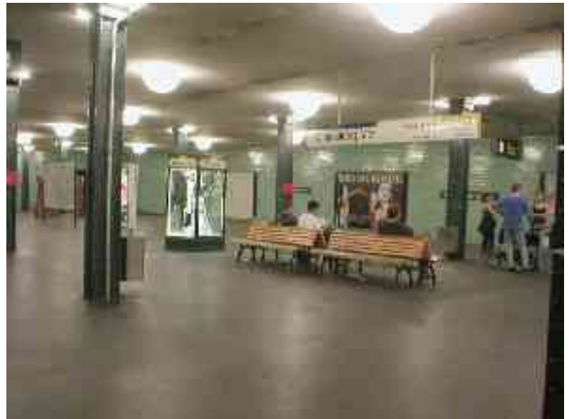
Abbildung 17 - U-Bahnhof Alexanderplatz vor Sanierung 2004/2005 (U8)
