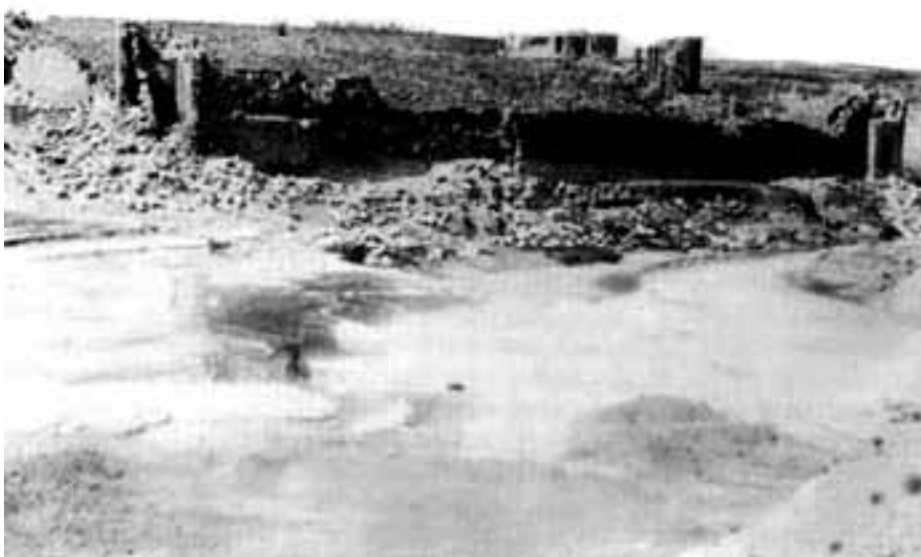
FIGURA 19.13 E 19.14 Haidra (Tunísia): Fortaleza bizantina, século VI. Detalhe e vista geral. (Fotos P. Salama.)
