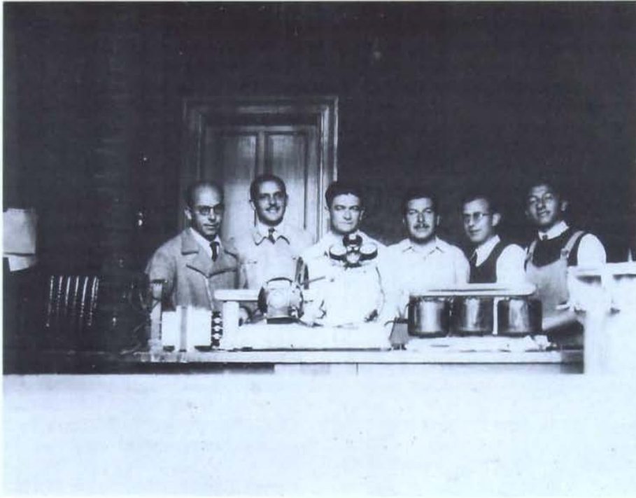
Técnicos de la UNLP realizando pruebas en el equipo transmisor de Radio Universidad
