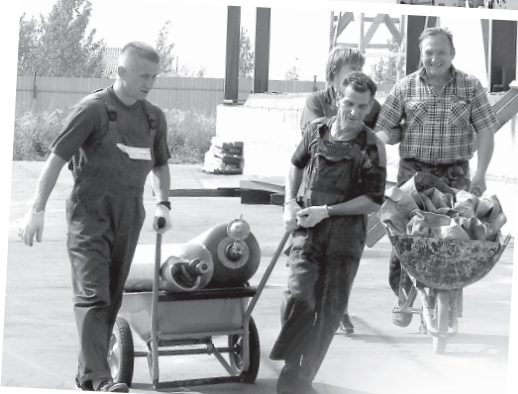
2007 год. В цехах ведется монтаж оборудования будущего завода, благоустраивается прилегающая территория...
