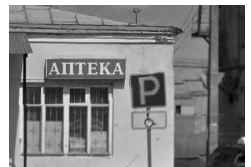
Конструкция не соответствует ширине оконного проема
