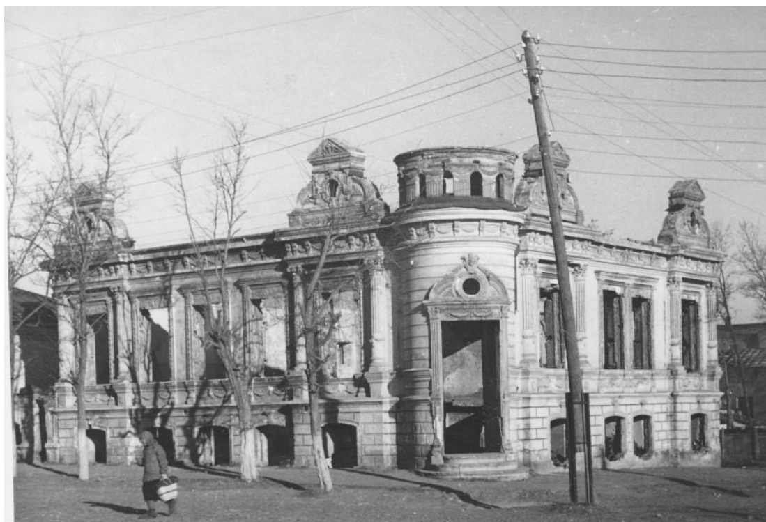
рис.2. Дом Кудрявцева в 1940-е/ Kudryavtsev's house in 1940s
