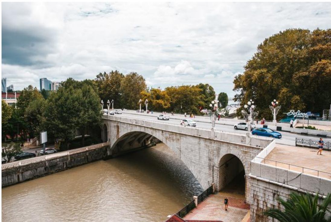
Рис. 3. Ривьерский виадук. Современное фото Page 3. Riviera viaduct. Modern photo URL: https://sochi.scapp.ru/scapp-gorod/mosti-sochi/
