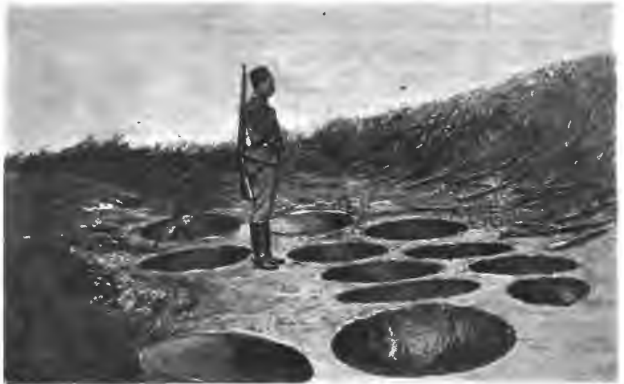
На австро-сербскомъ театрѣ военныхъ дѣйствій. Волчьи ямы, вырытыя австрійцами. На днѣ каждой такой ямы, глубиною въ 6—7 англійскихъ футовъ, воткнутъ заостренный коль.
