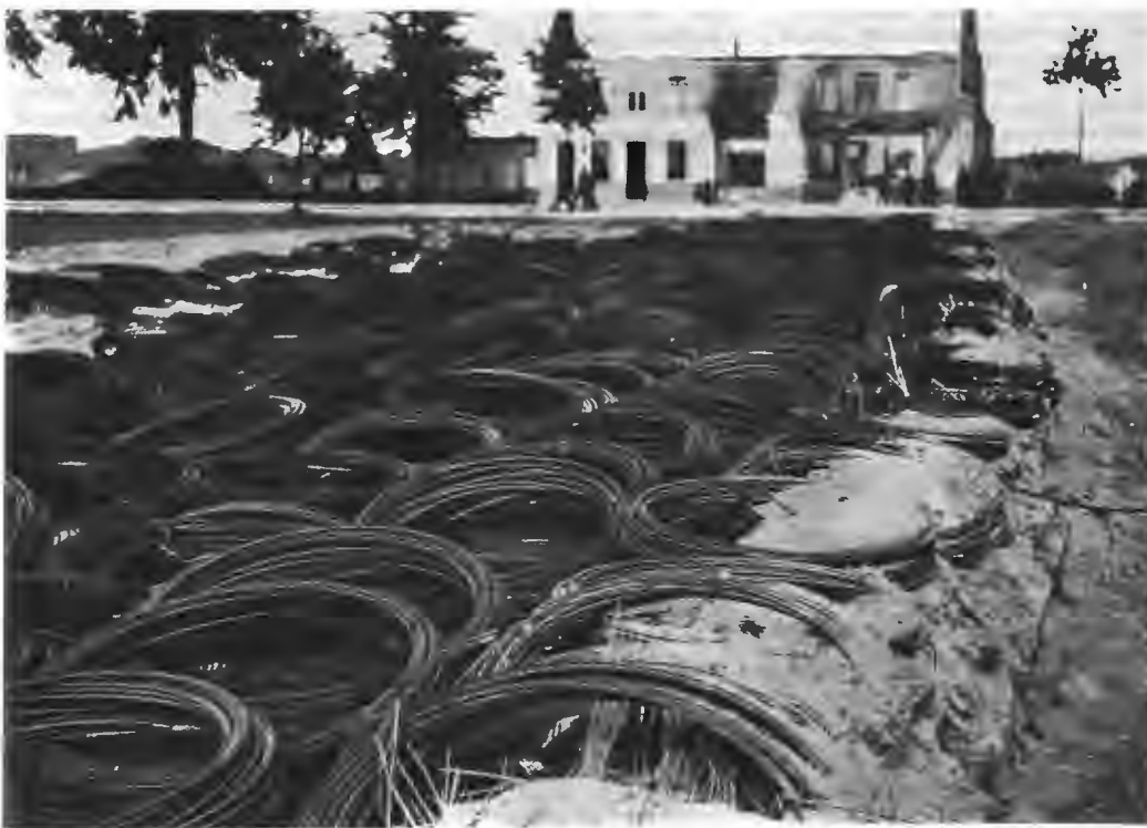
Германскія траншеи олизъ Гента, защищенныя по новой системѣ кругами стальной проволоки, которая ослабляетъ силу шрапнельнаго огня и прелятствуетъ осколкамъ снарядовъ разлетаться въ стороны.
