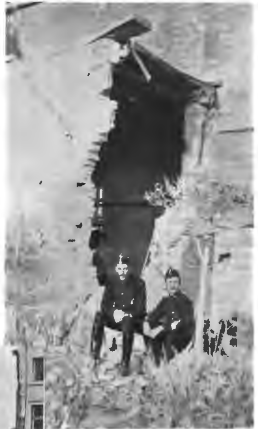
Малинь. Домъ, разрушенный германскимъ снарядомъ.
