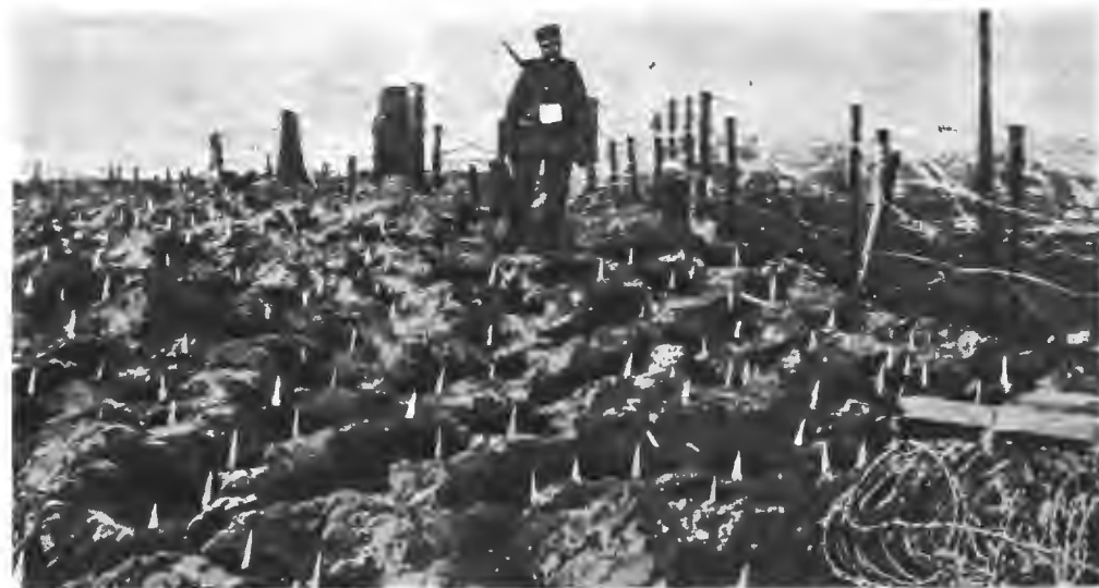
На австро-сербскомъ театрѣ военныхъ дѣйствій. Волчьи ямы съ проволочными заграждениями, вырытыя на значительномъ пространствѣ въ австрійскихъ придунайскихъ провинціяхъ для отраженія атакъ сербовъ. Ямы эти, разной глубины, расположены неправильными рядами впереди позицій, и въ каждой изъ нихъ вбитъ острый коль.
