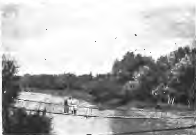
Осмотръ проволочнаго мостика передъ прохожденіемъ войскъ.
