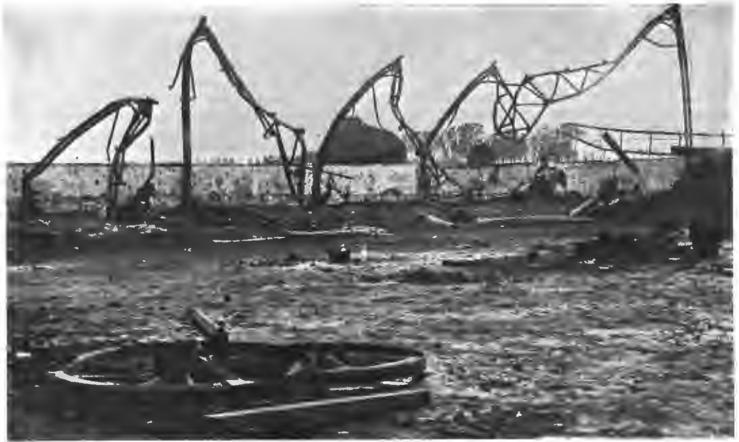
Франція. Развалины вокзала маленькой желѣзнодорожной станціи, разрушенной германскими войсками.
