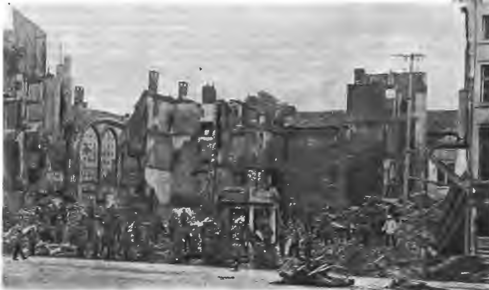
Льежъ. Церковь, разрушенная бомбардировкой
