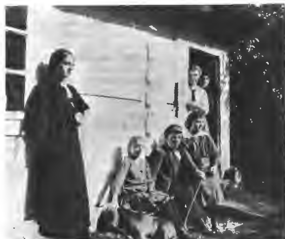
Жители г. Томашева у своихъ жилищъ, разрушенныхъ шрапнельнымъ огнемъ.
