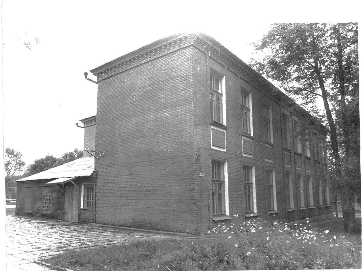
Общий вид с северо-запада.
