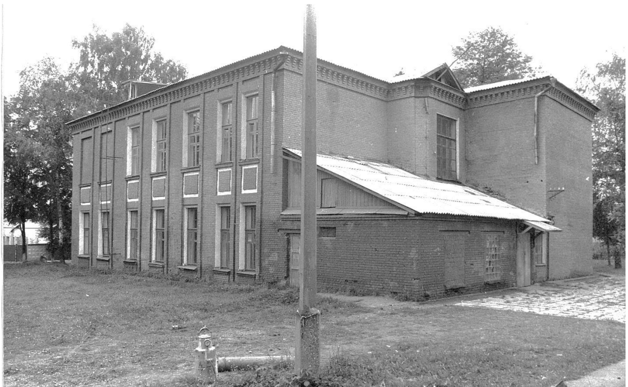
Общий вид с северо-востока.
