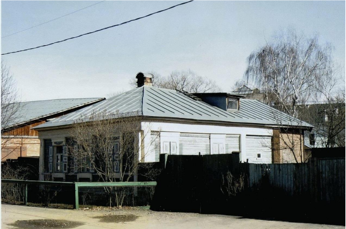
Фото № 3. Общий вид с юго-запада.
