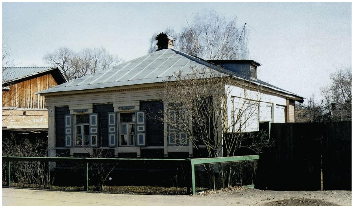
Фото № 2. Вид с юго-запада.
