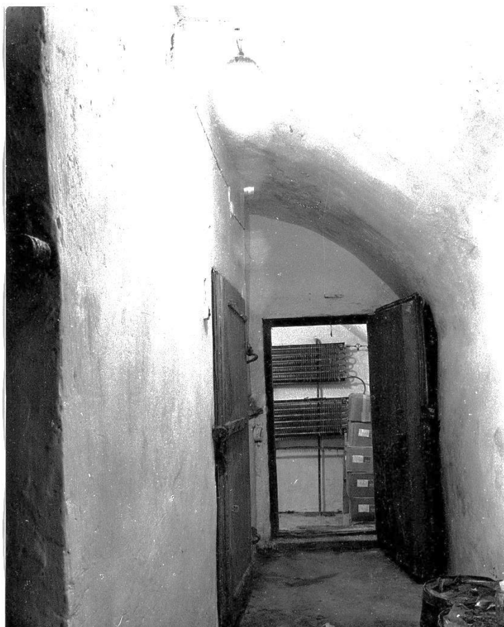
Интерьер западного подвала. Вид на юг.
