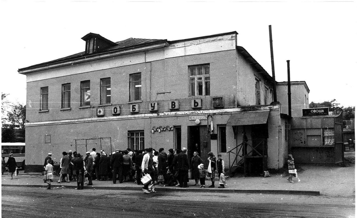
Общий вид с северо-востока.
