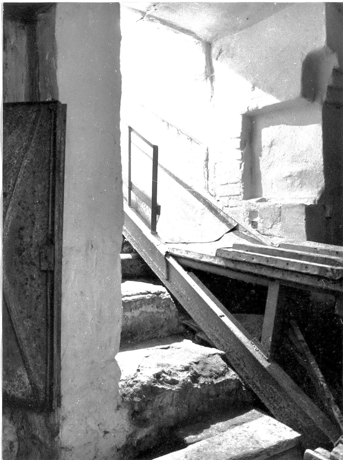
Лестница в западном подвале.
