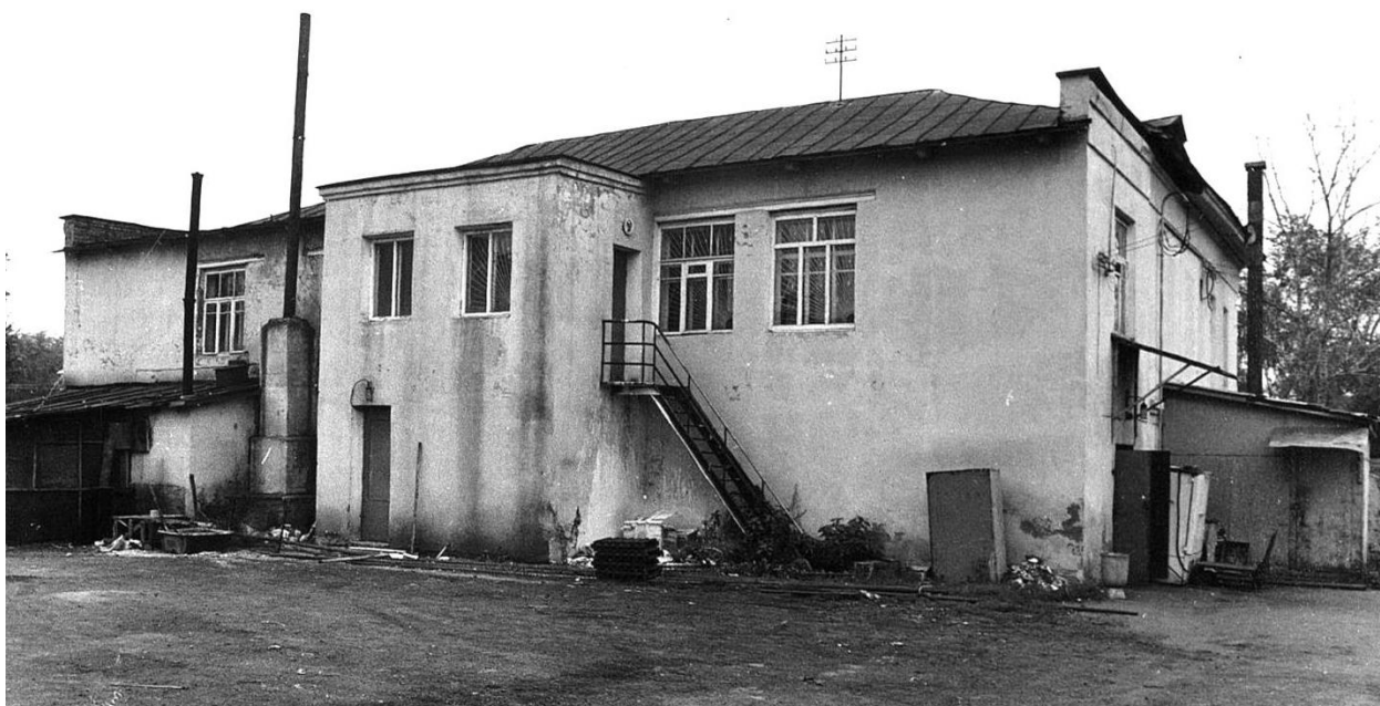
Общий вид с северо-запада.
