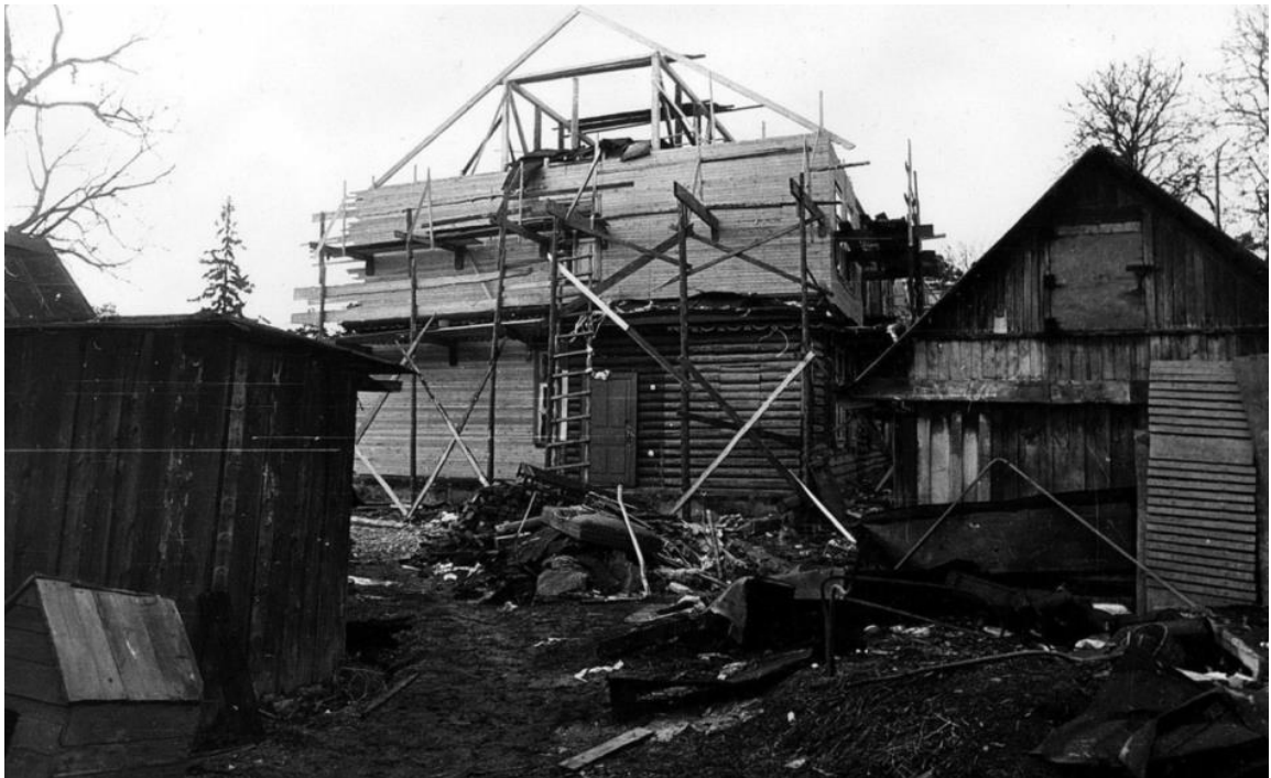
Общий вид с северо-запада.
