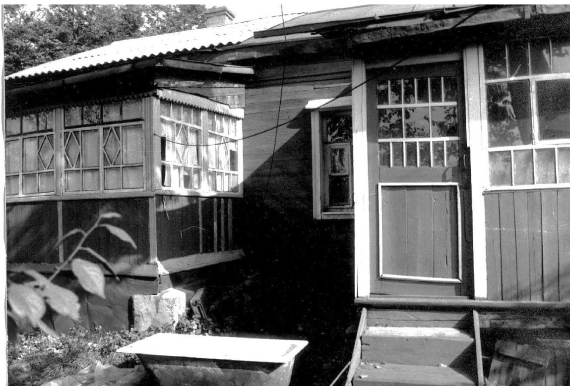
Фрагмент южного фасада.
