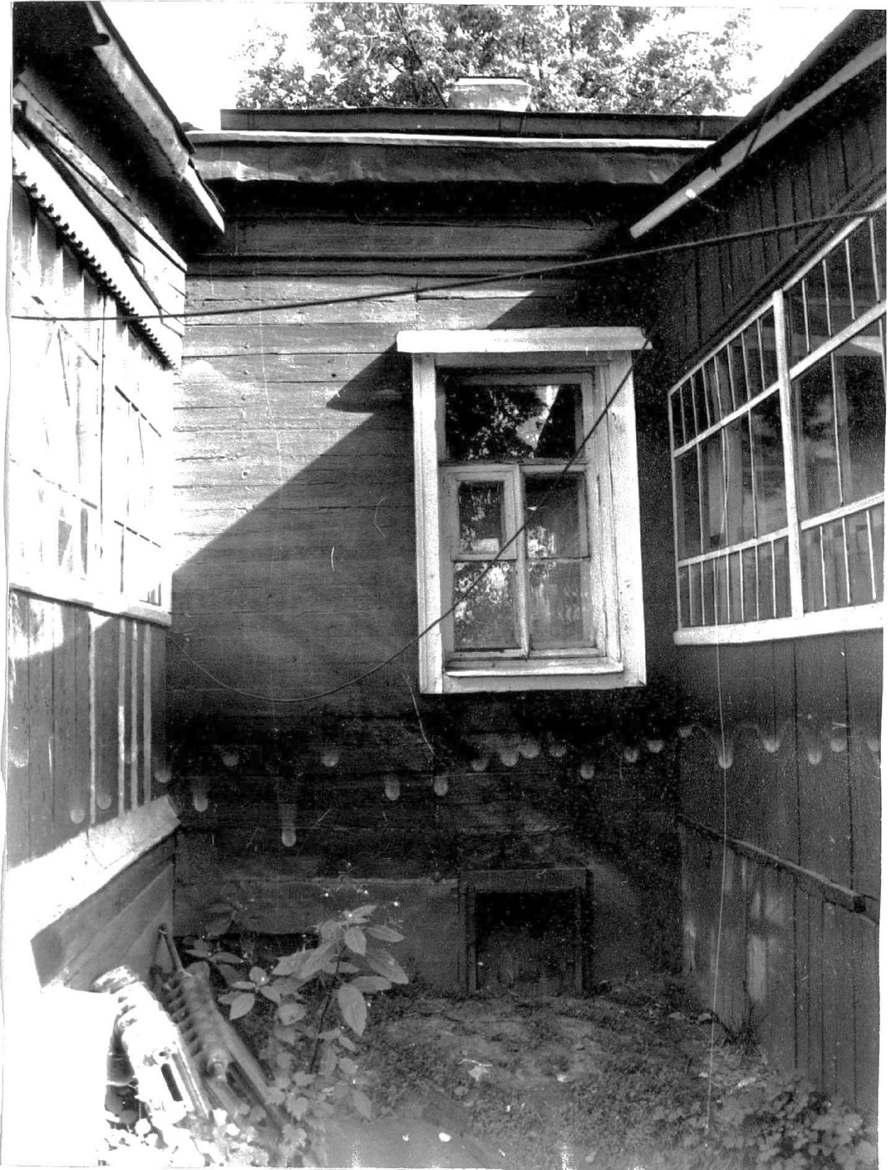
Фрагмент южного фасада.
