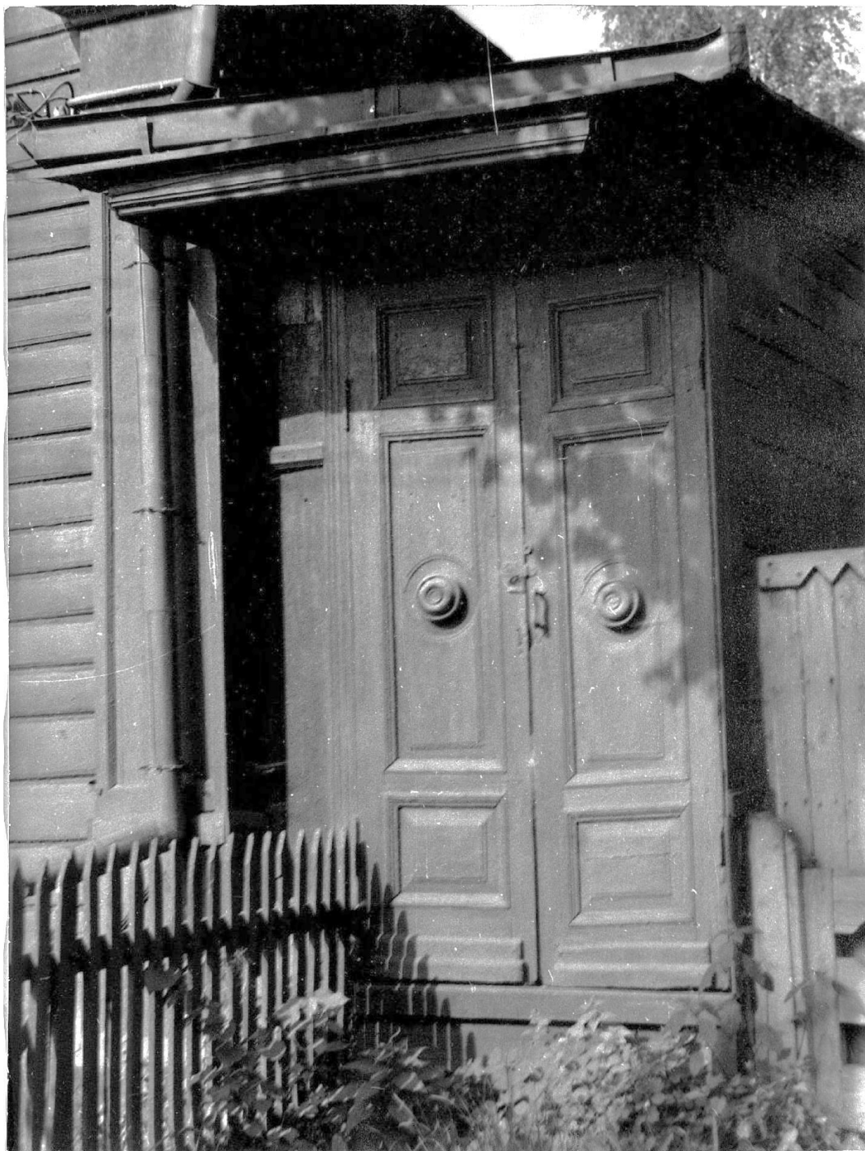
Пврдный вход на восточном фасаде.
