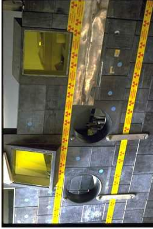
Abb. 97 Die Blei Abschirmung um die Flowbox aus einer anderen Perspektive.
