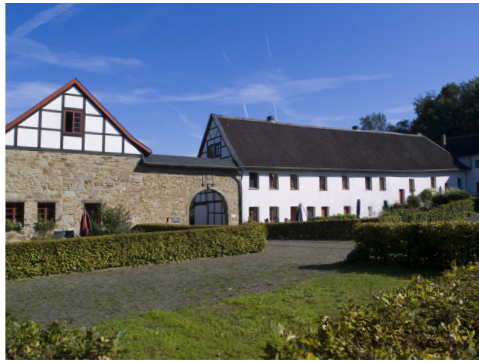
Haus Heisingen – Ansicht von Westen (2010)
