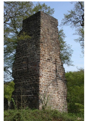
Ruine des Kattenturms – Westansicht (2006)
