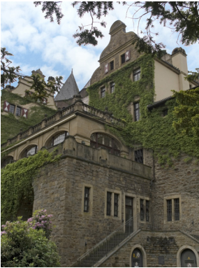
Der Wintergarten (Mitte) und das dreigeschossige Wohngebäude (oben rechts) Landsbergs
