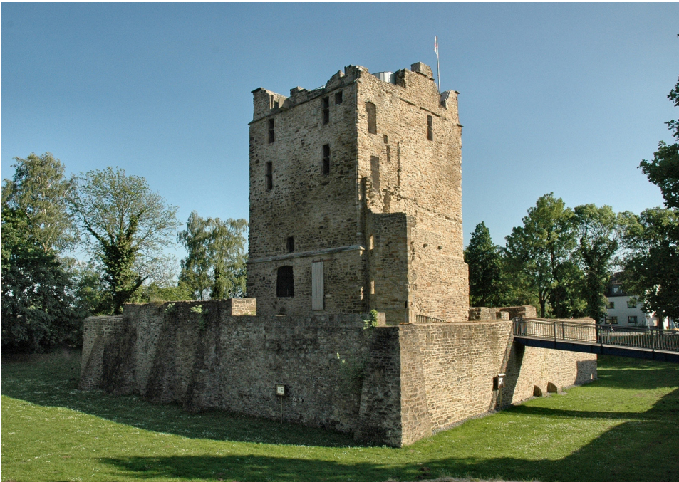
Kernburg der Burg Altendorf – Ansicht von Norden (2007)
