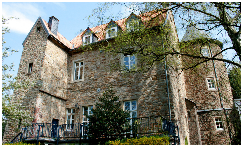
Gartenfassade des Hauses Heck (2009)
