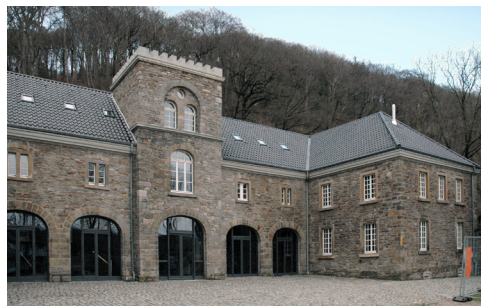
Die nach einem Brand wiederhergestellte Remise des Schlosses Baldeney (2007)
