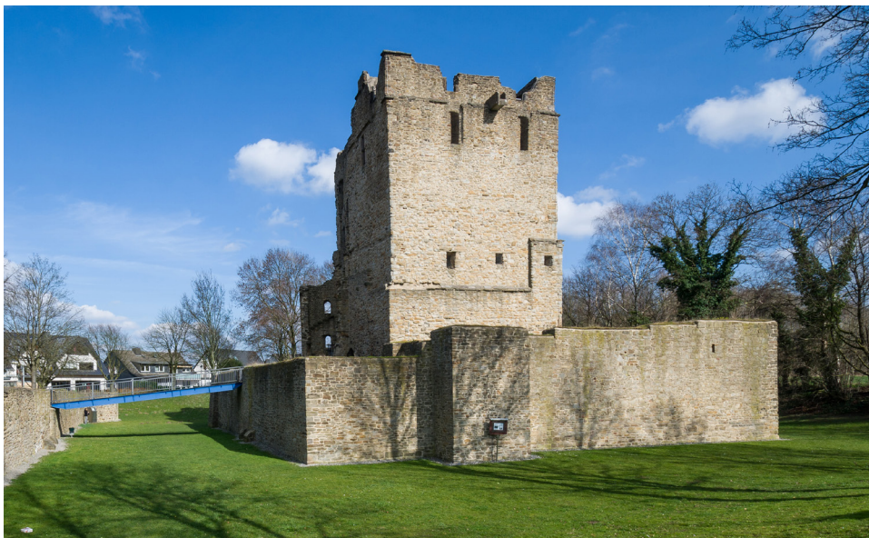
Kernburg der Burg Altendorf – Südwestseite (2014)
