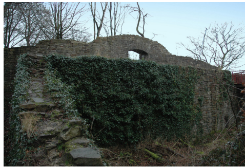
Zwingermauer und das dahinter liegende Tor der Neuen Isenburg (2007)
