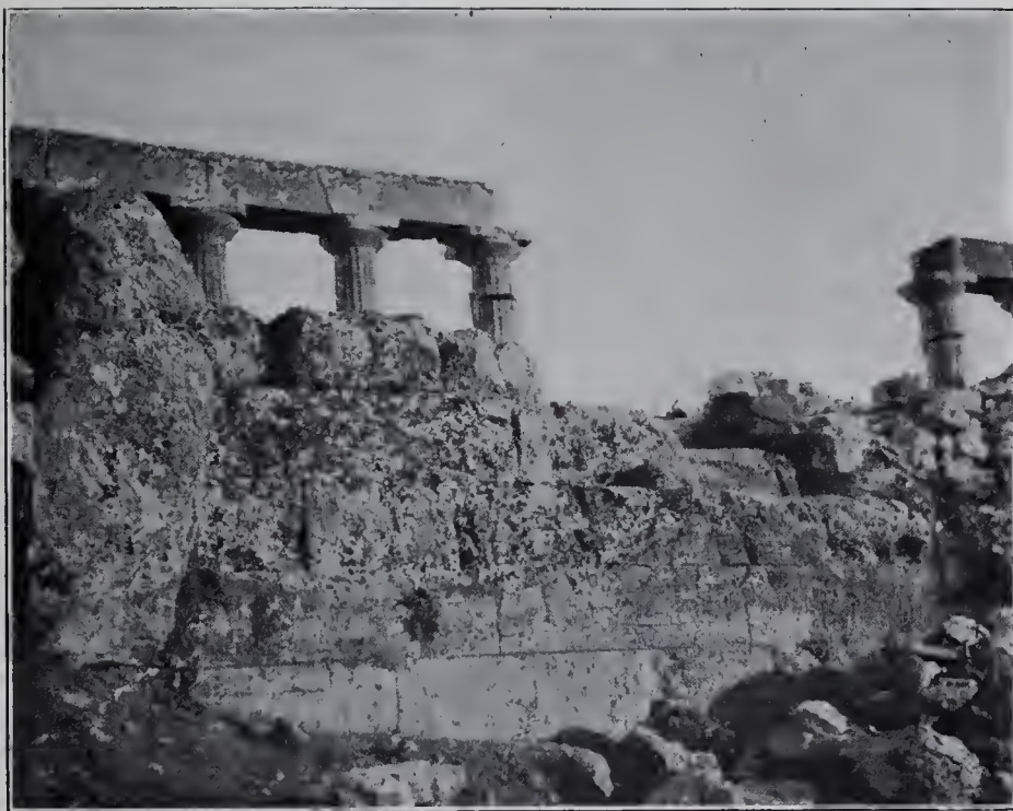
Abb. 45. Die Nordterrassenmauer von aussen.
