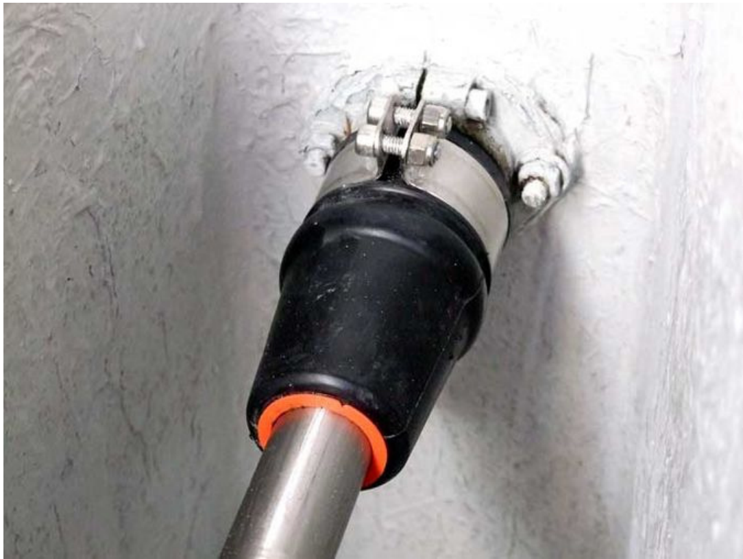
Vérification de l'alignement de l'arbre d'hélice
