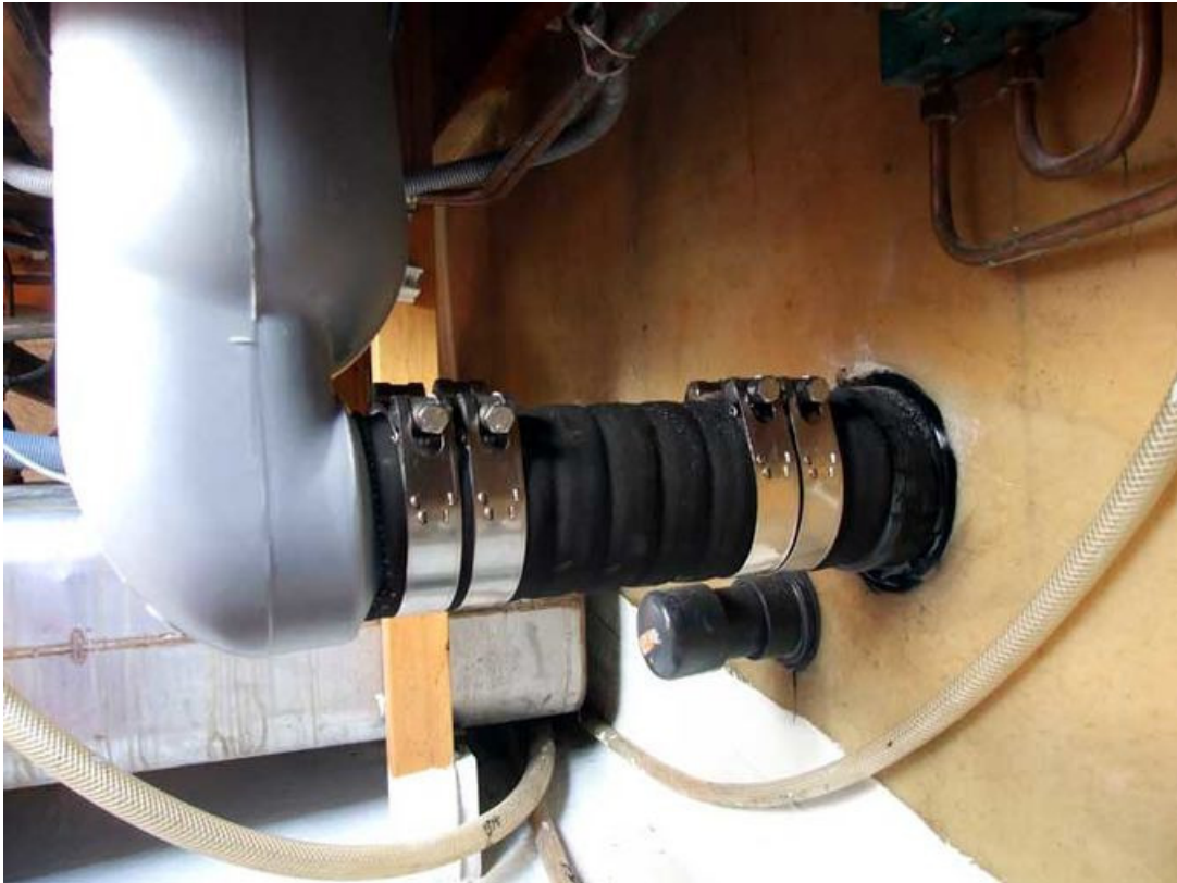
Échappement, mise en place du col de cygne de 90 mm
