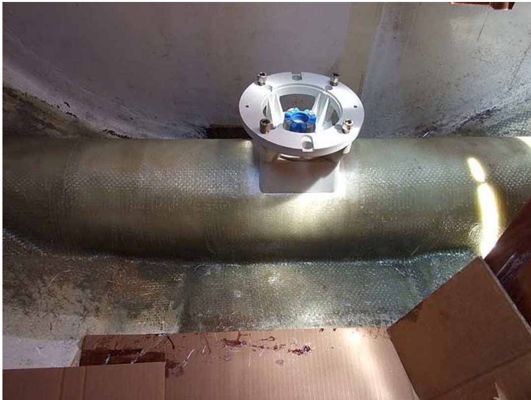
Stratification du tube, et pose du support moteur.
