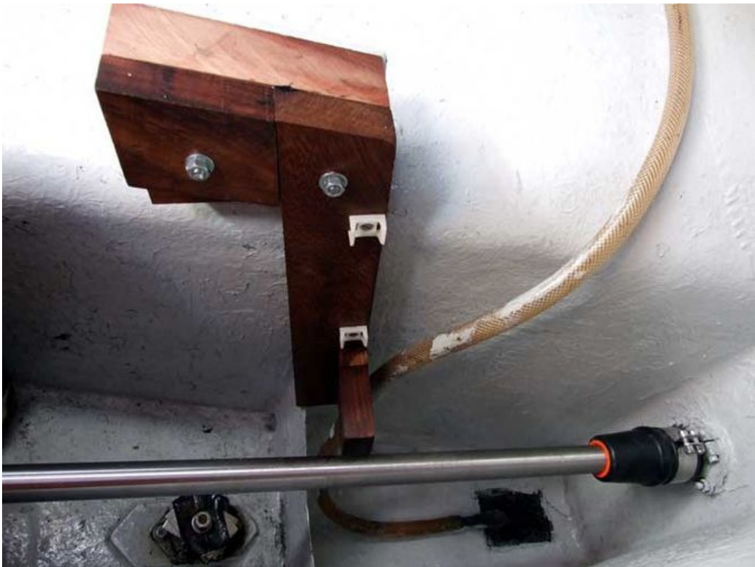
Échappement, mise en place du support de "waterlock"
