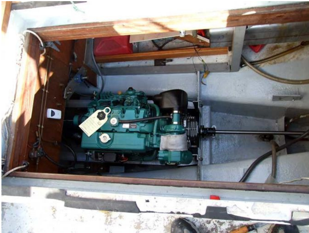
Alignement du support moteur
