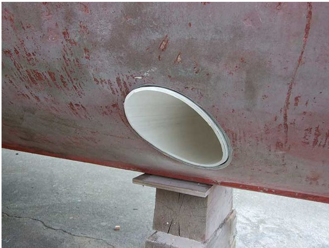
Pose du tube et préparation à la stratification à la résine époxyde.
