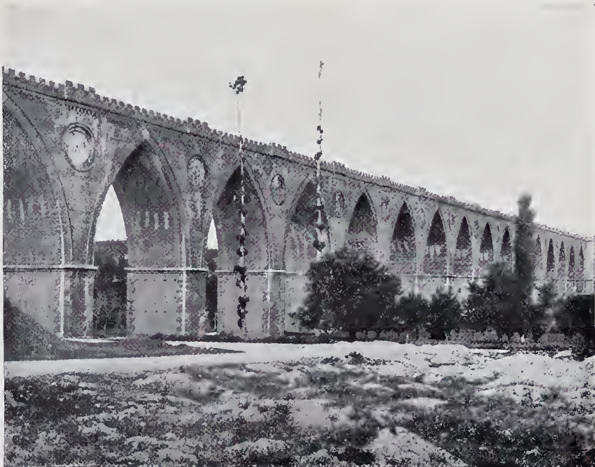
DESENZANO — PONTE DELLA FERROVIA.
