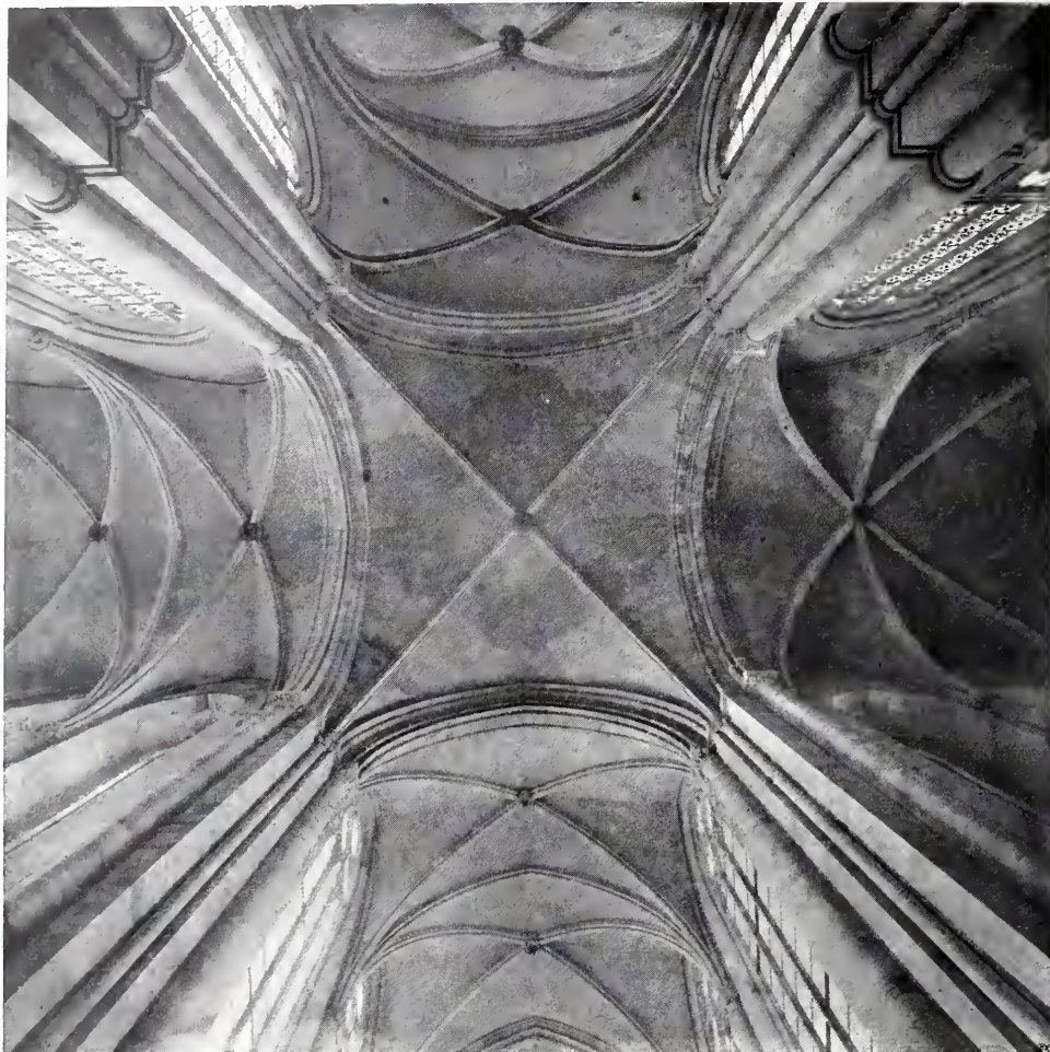
Abb. 139. Magdeburger Dom. Gewölbe des Chores, der Mittel- und Querschiffe
