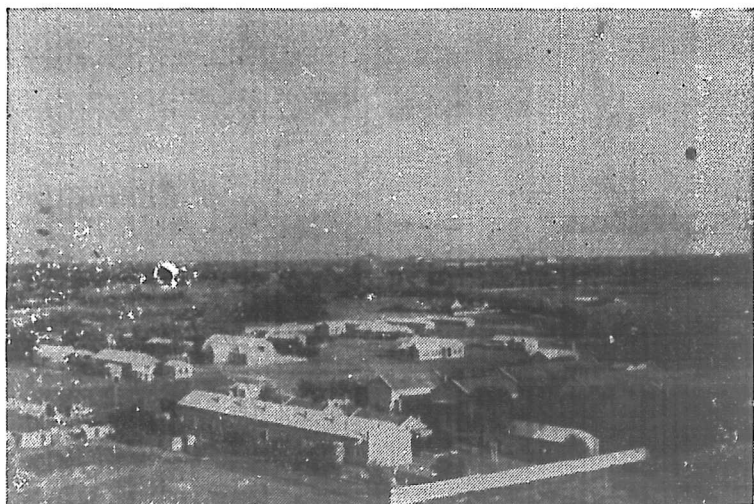
訓練部建築物全景（北京本場）
