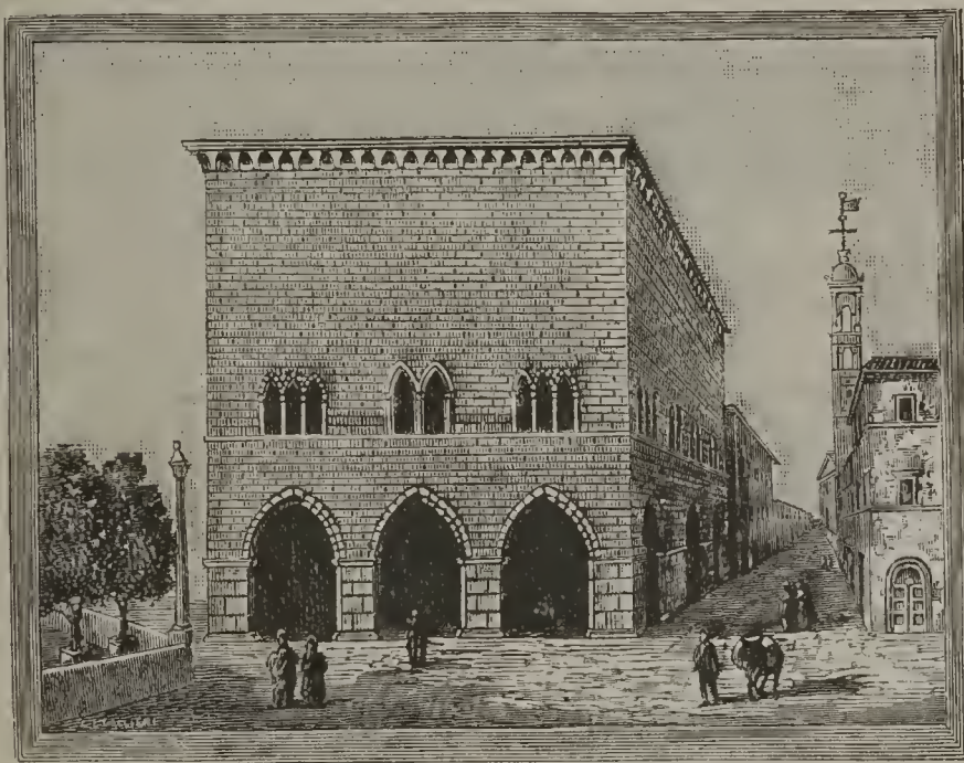
Un lato del palazzo di Piperno.
