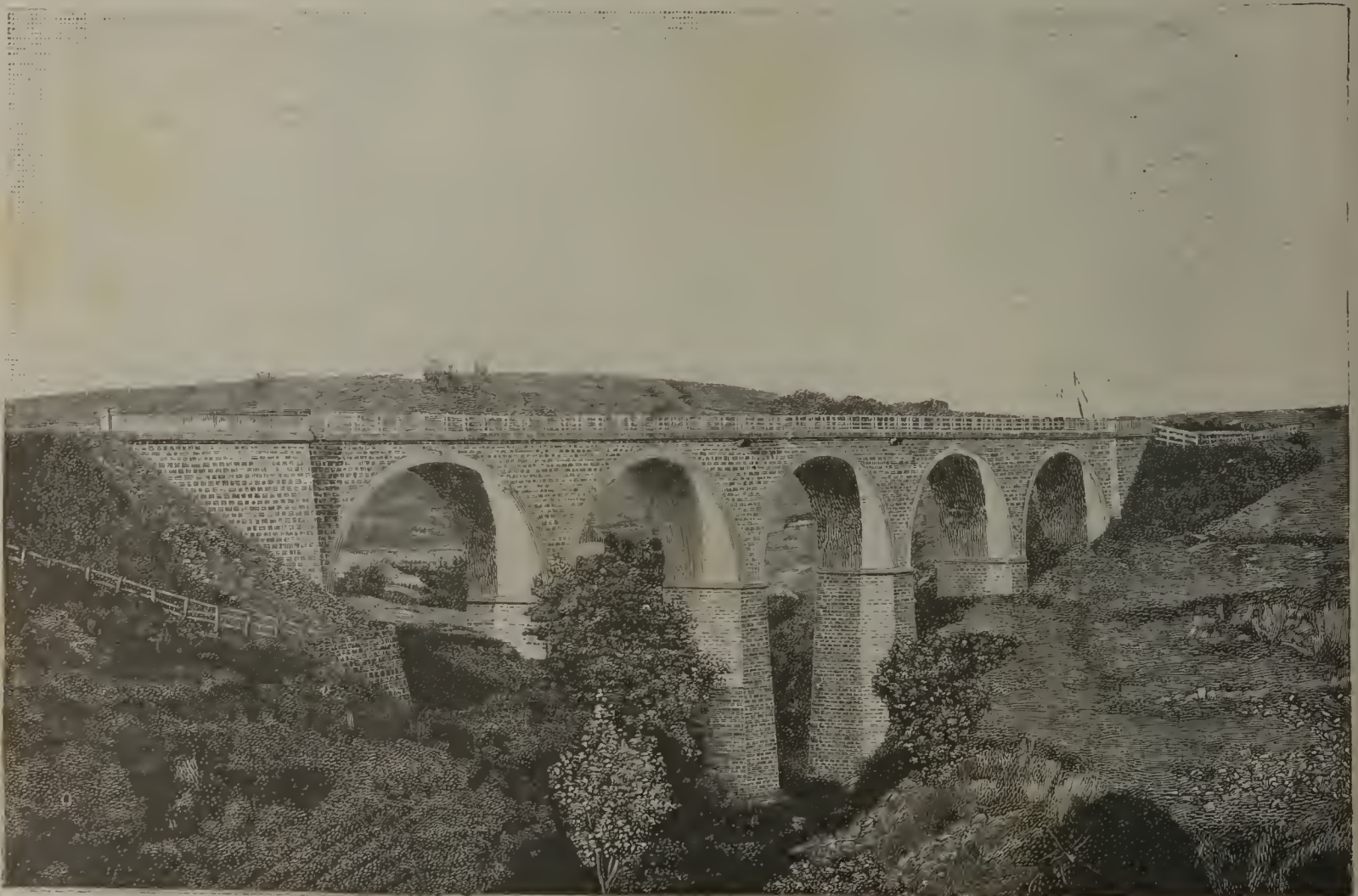
Viadotto sul rio Piscari.
