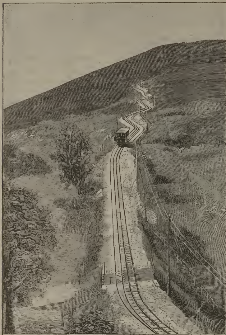
Ferrovia elettrica del m. Salève. (Veduta generale).
