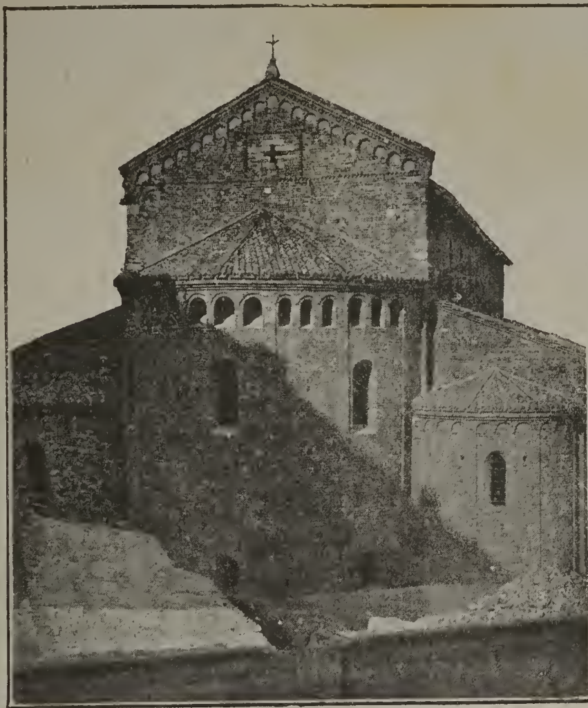
Fig. 2. — Abside restaurata della Basilica di S. Vincenzo in Prato.
