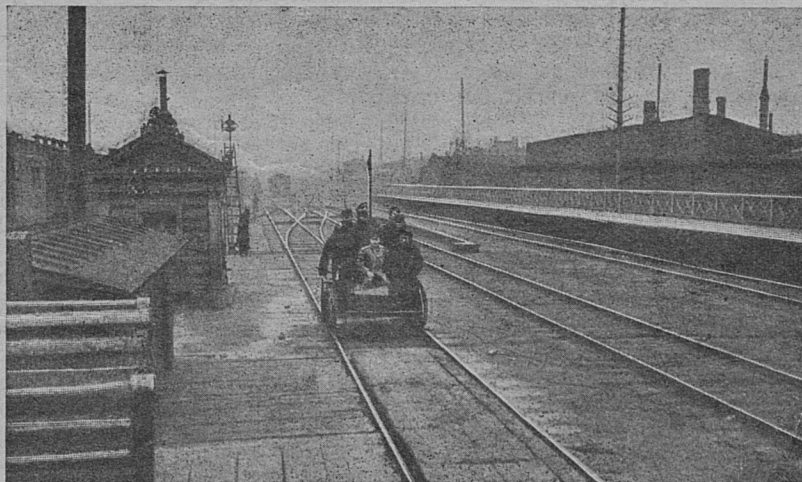
По Николаевской желѣзной дорогѣ. — Развозъ провизіи по линіи охраны.
