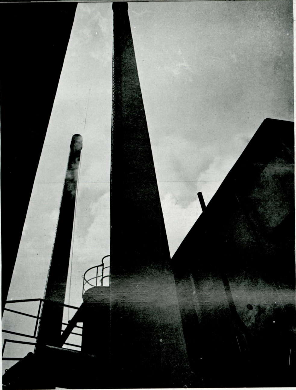
Cheminées de la verrière de Paşabahçe (Istanbul)
