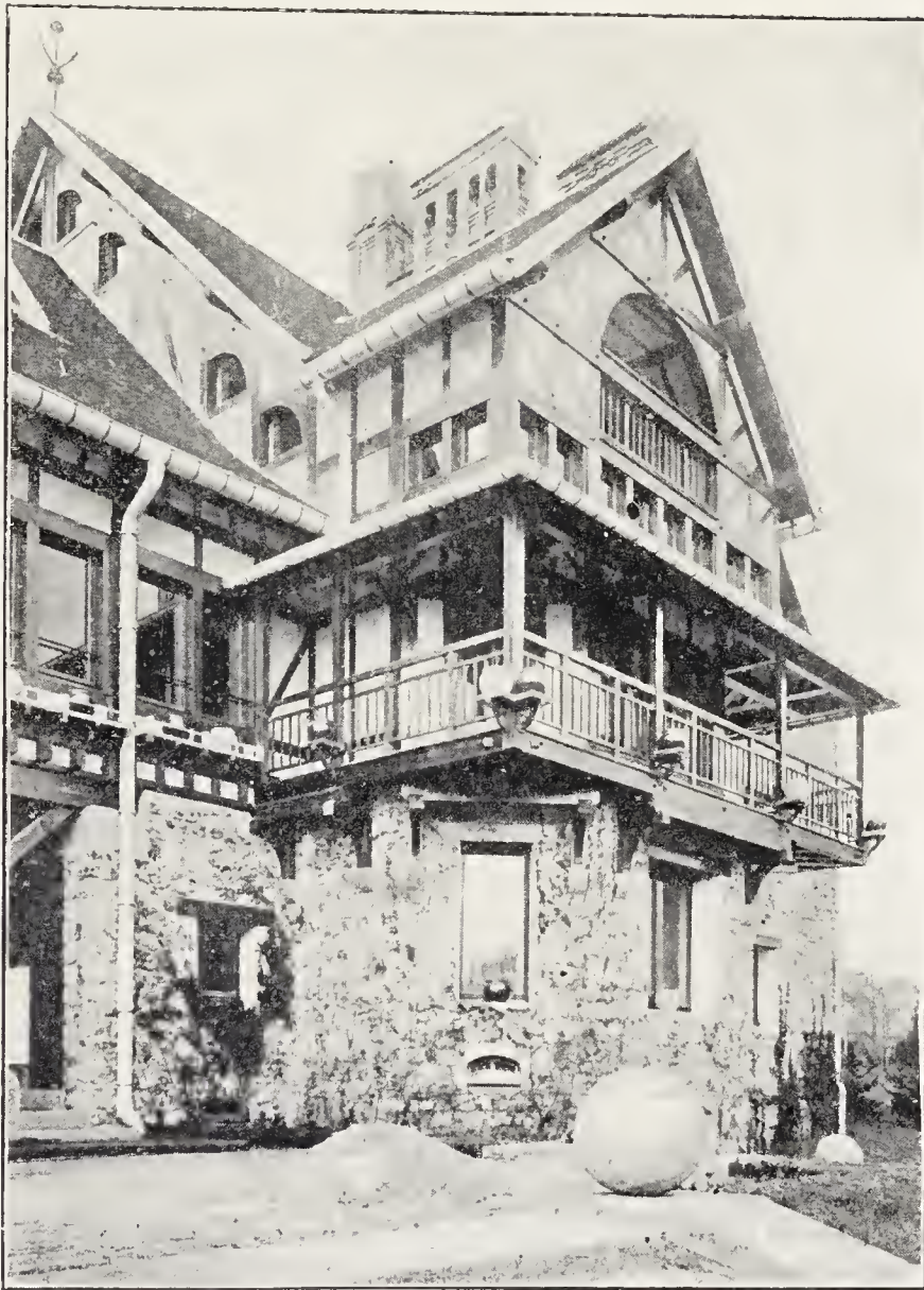
Fig. 10. — Vue d'un hôtel aux environs de Paris. — M. Bonnier, architecte.
