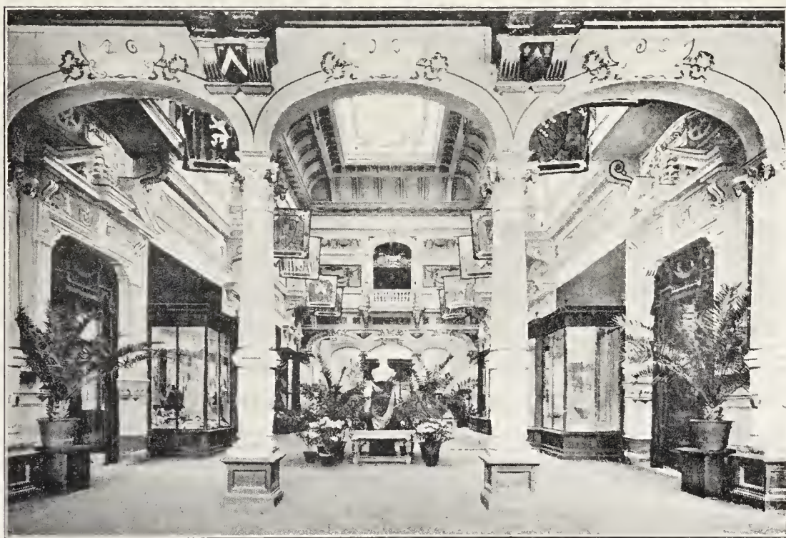
Fig. 12. — Vue intérieure du Pavillon de la Belgique.
