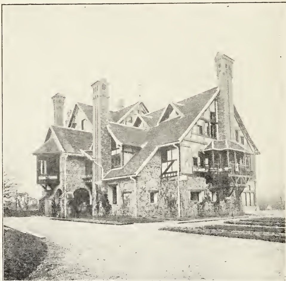
Fig. 11. — Vue d'un hôtel aux environs de Paris. — M. Bonnier, architecte.
