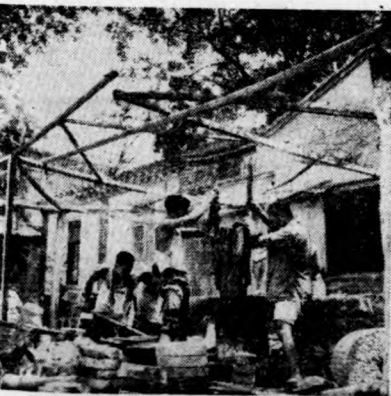
同学们正在耐火材料厂工地施工 杨百顺摄
