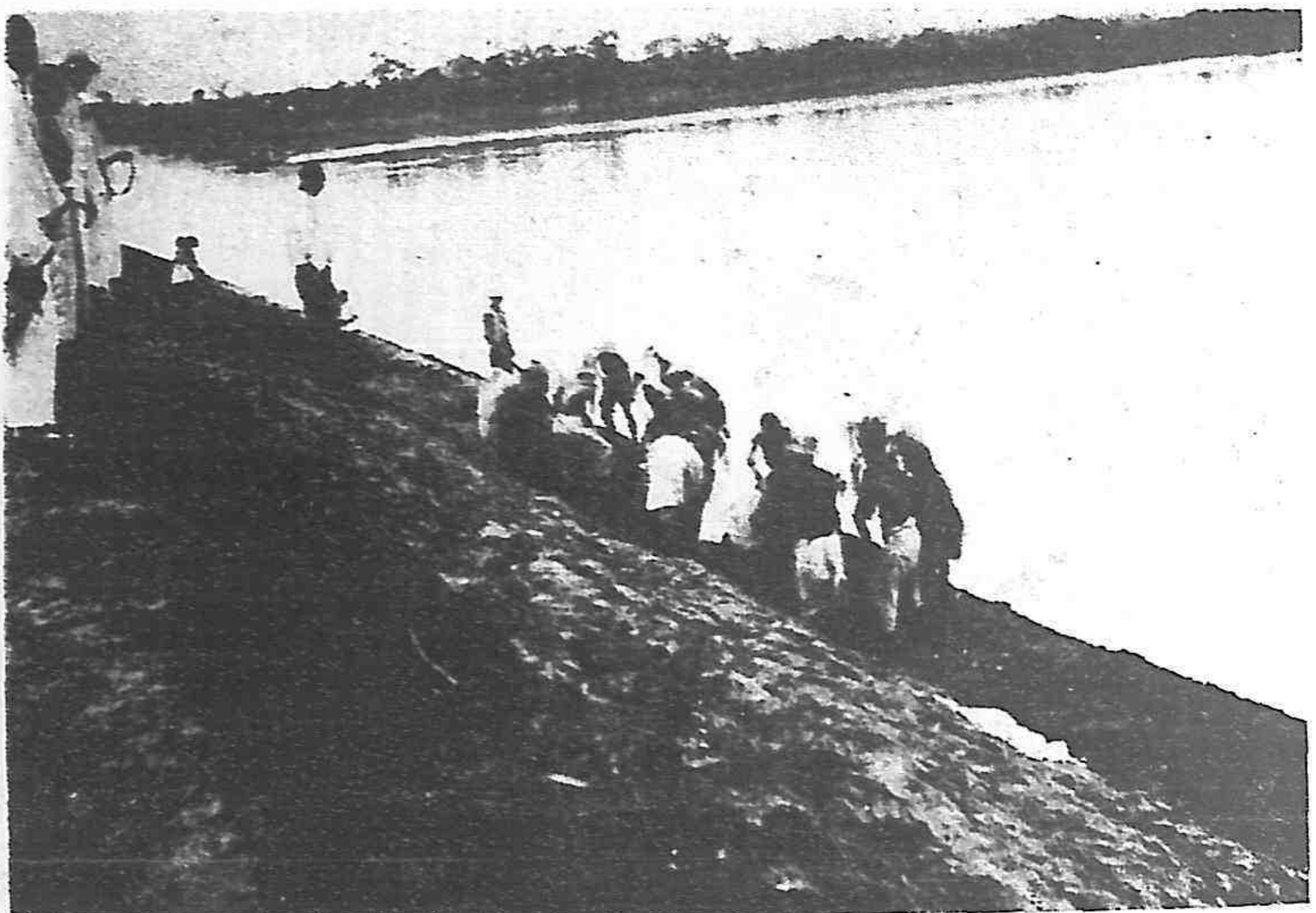
江都段擺渡口北向張姓石標處幫築脫坡工
