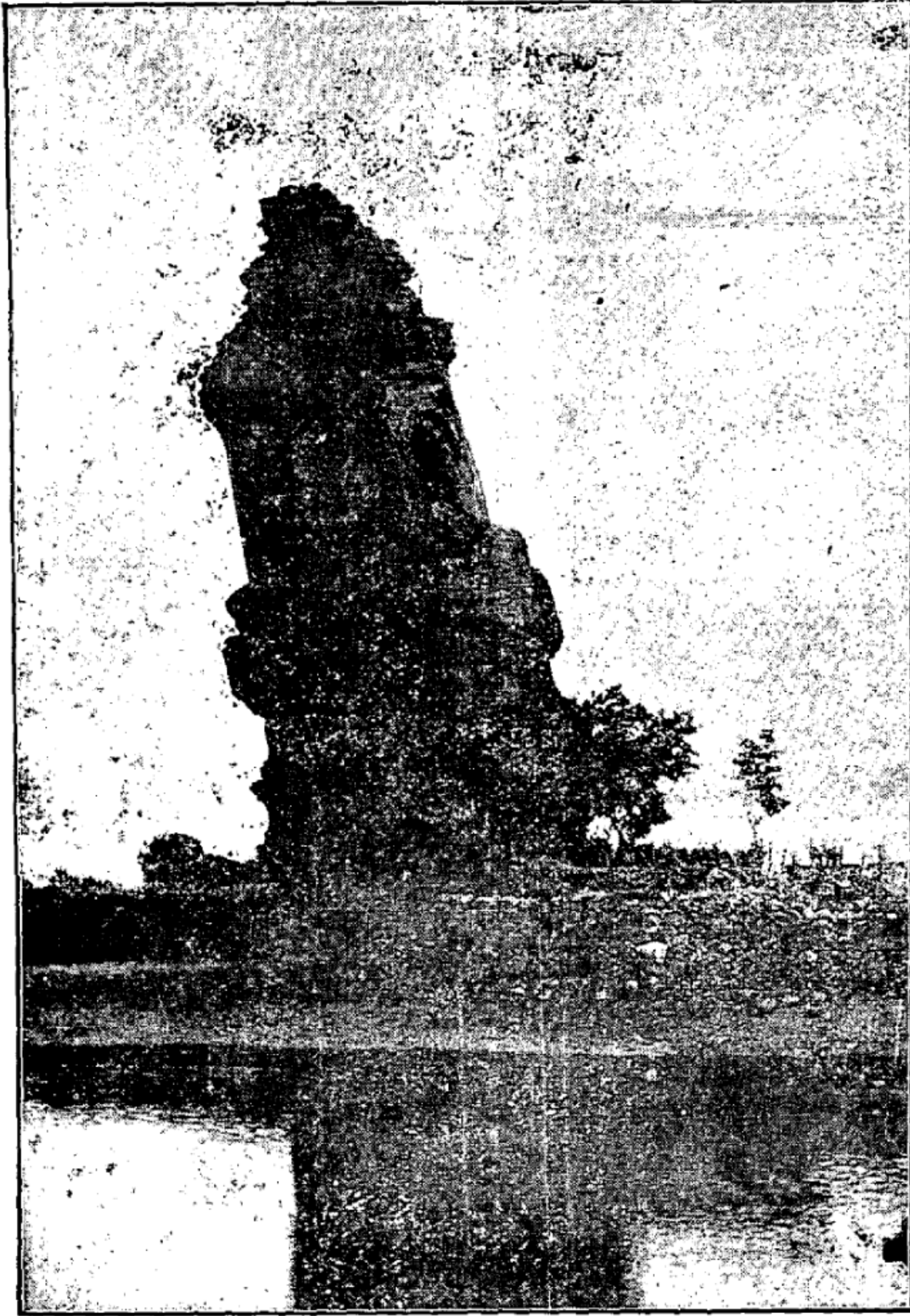
不峙尙力重失歪形在成灰用築所時北鎮前中在歪 倒立能然心却斜已塔現築磚純建代魏係衛縣綏塔
