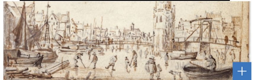
Schaatsers bij de Montelbaantoren in Amsterdam, door Aert van der Neer (p. 133)
