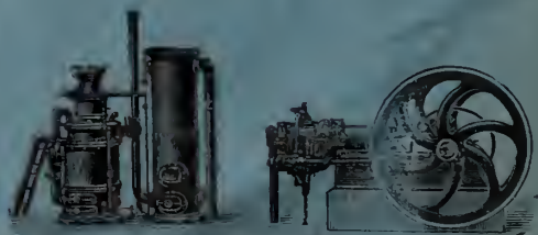
Installation à gaz pauvre.
