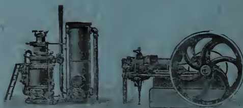
Installation à gaz pauvre.
