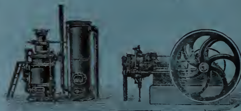
Installation à gaz pauvre.
