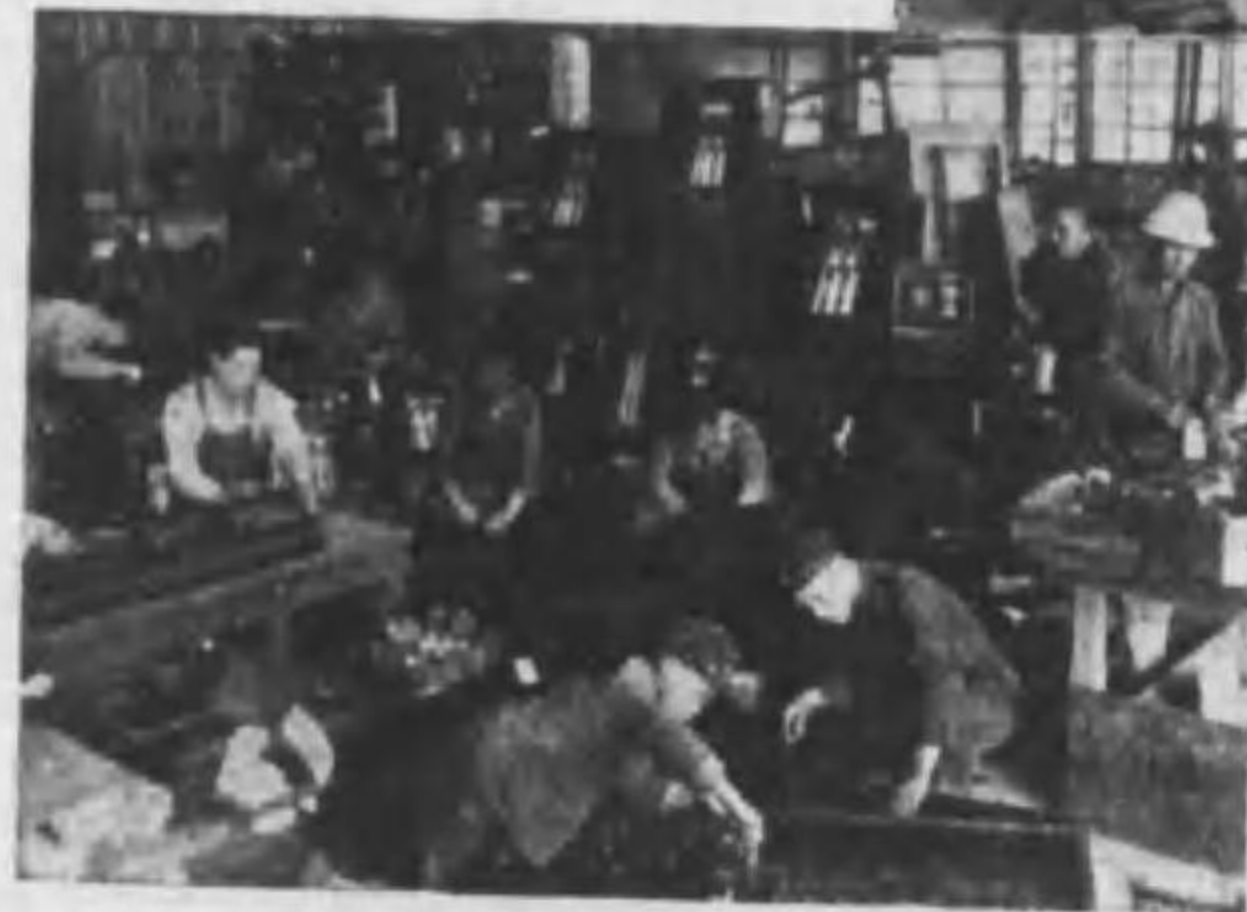
分電盤組立工場の一部
