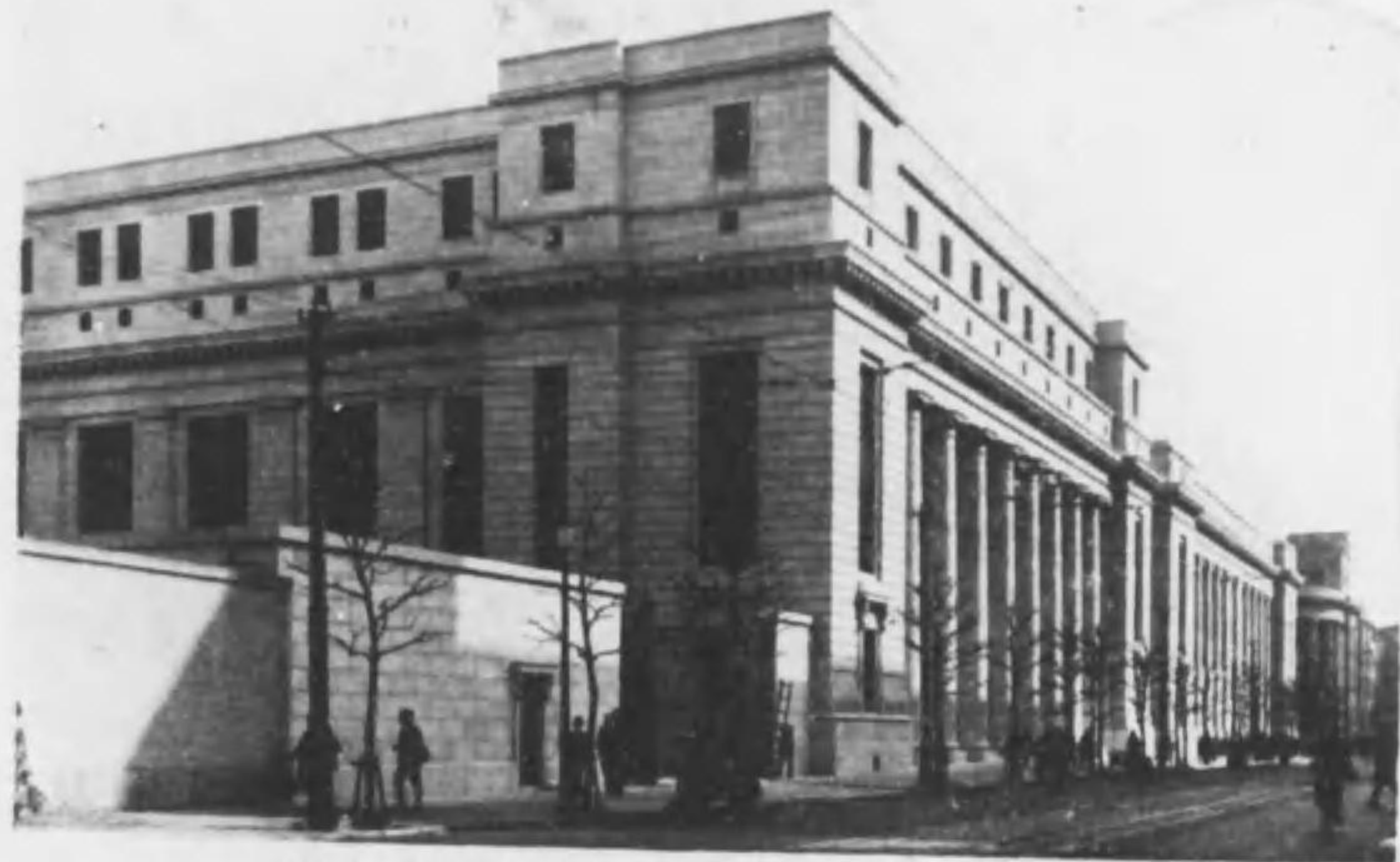
弊社ニテ電氣工事一式施工ノ三菱銀行本店新館 (工期2ヶ年 請負額159,000圓)
