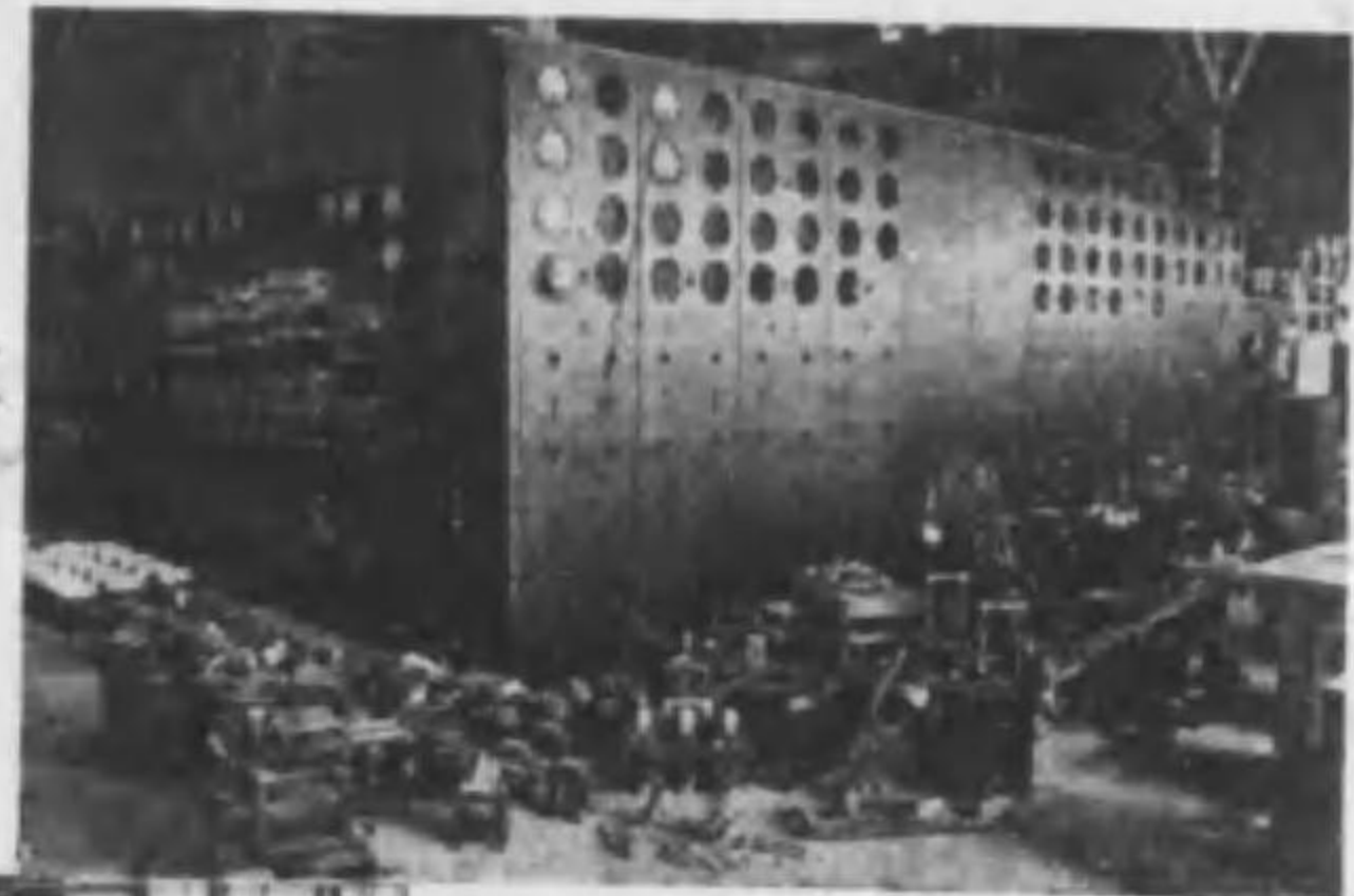
配電盤組立工場の一部
