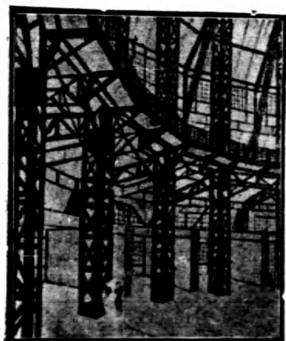
Fig 38. 構造派 Posem 水塔內部
