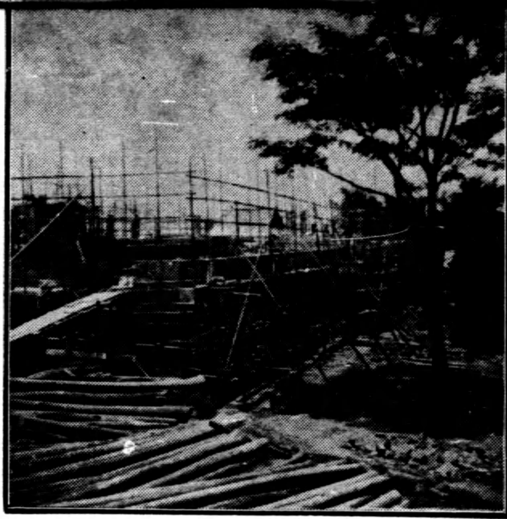
宿舍施工情形 (七月間)
