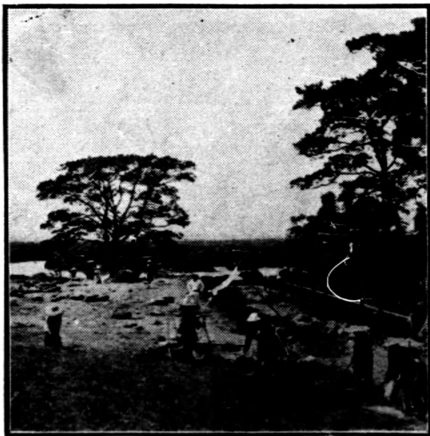
工學院地基工程情形 (八月間)
