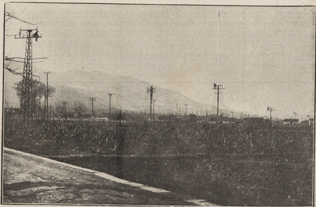
威壩電廠輸電綫放線工作情形
