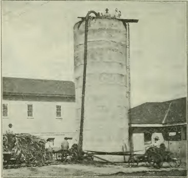
Filling the Silo.
