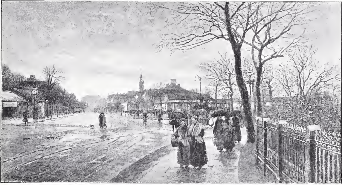
Der Karlsruher Bahnhof. Von Fr. Kallmorgen.
