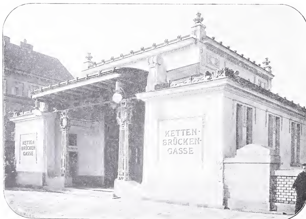
Die Station »Kettenbrückengasse« der Wiener Stadtbahn.
