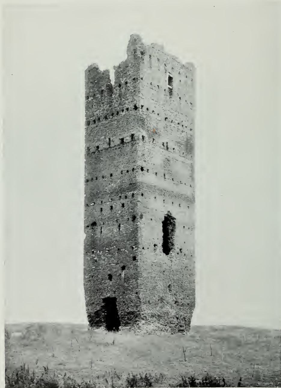
TORRE DELLE CORNACCHIE.
