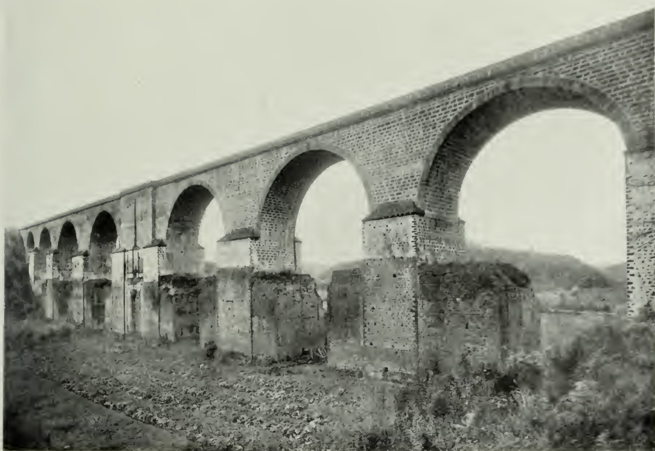
PONTE SULLA VIA DI SUTRI.
