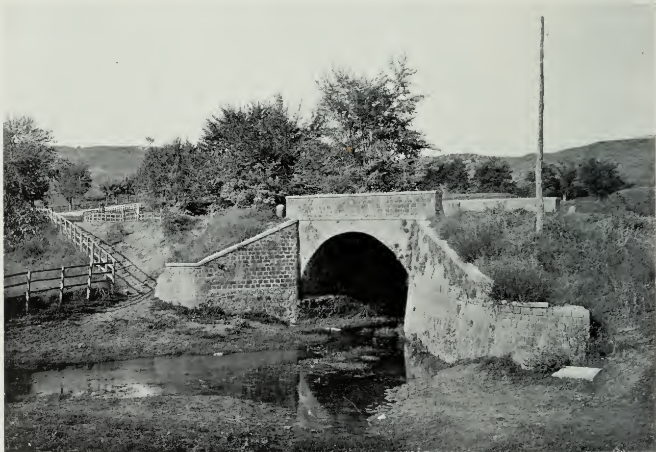
PONTE DELL'ACQUA TRAVERSA.
