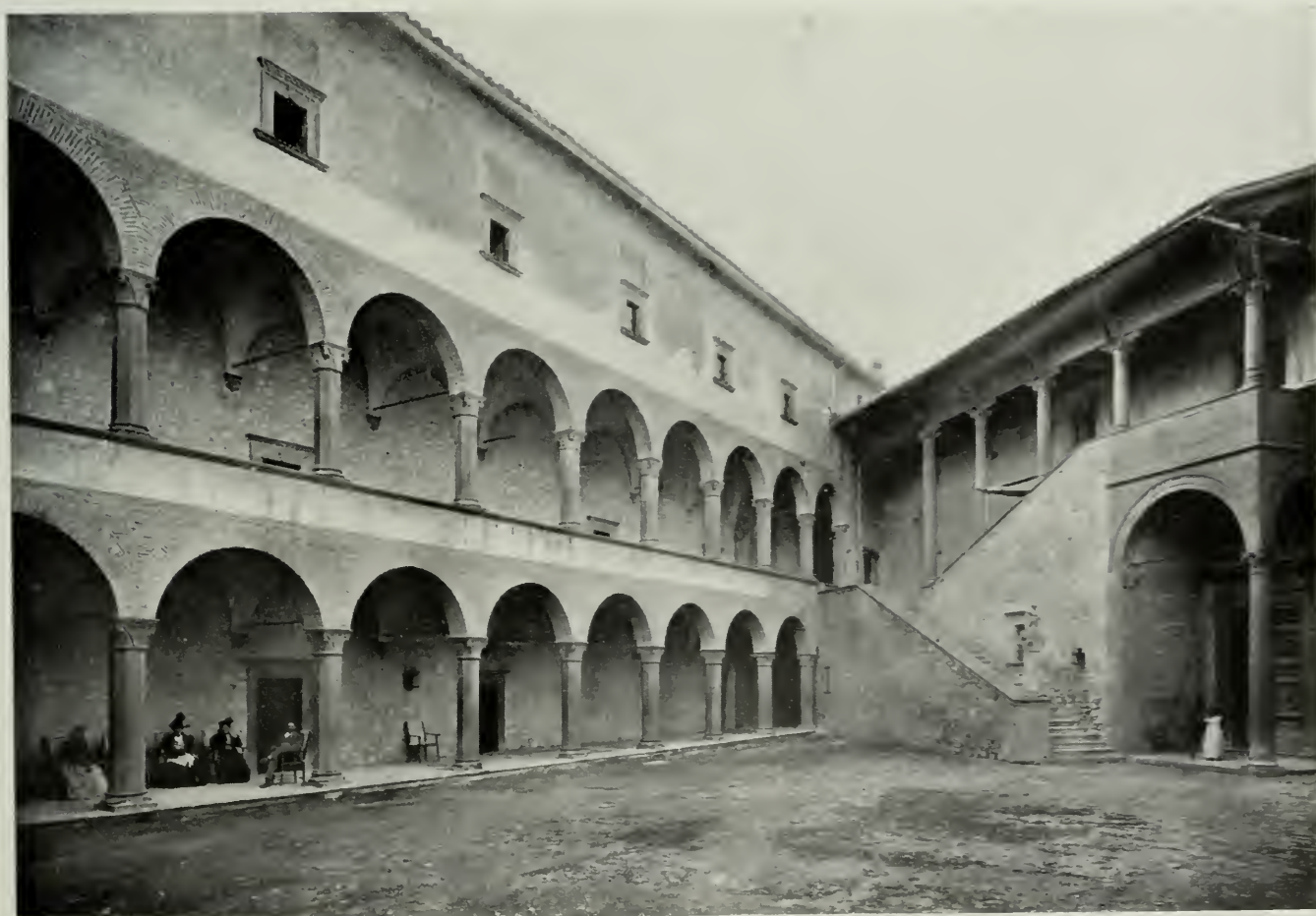
BRACCIANO — CORTILE DEL CASTELLO.
