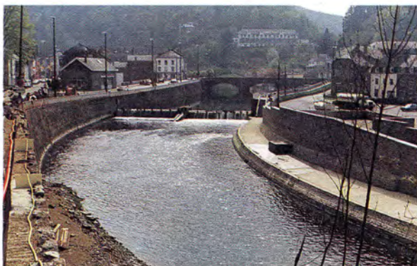
Dispositif anticrue dans le quartier des Evêts à La Roche-en-Ardenne.
