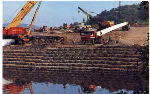
Berge protégée par des gabions
