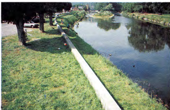
Cité Delrée à Tilff – Muret anticrue
