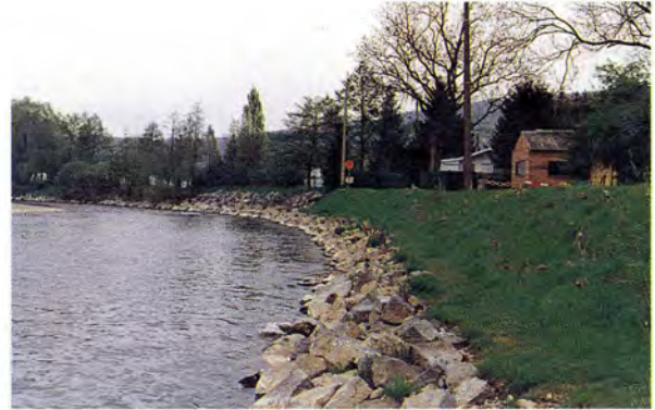
Berge protégée par enrochements
