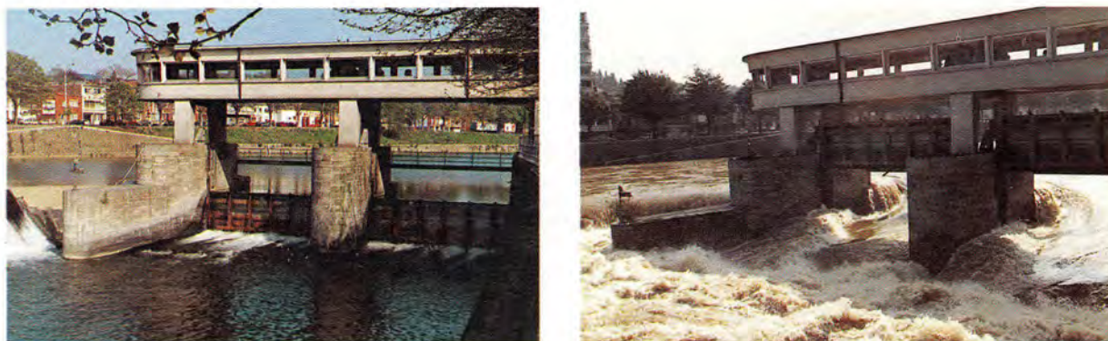
Barrage des Grosses -Battes à Angleur – Un débit qui peut atteindre 800 m^3/s (crue de 1980).
