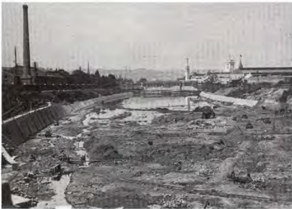
Nouveau tracé de l'Ourthe avant sa mise sous eau à Angleur (1905)
