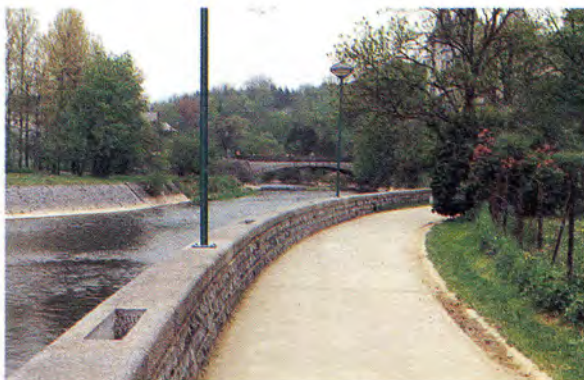
Mur anticrue à Durbuy
