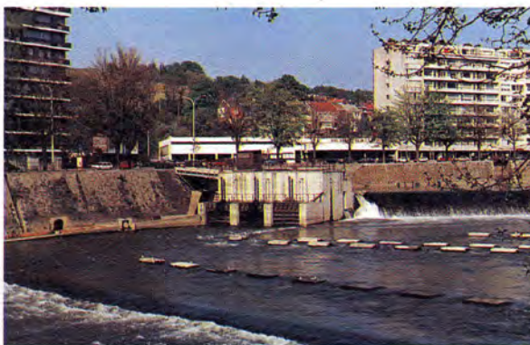
La microcentrale des Grosses-Battes à Angleur mise en service en 1984
