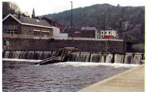
Le barrage mobile de La Roche
