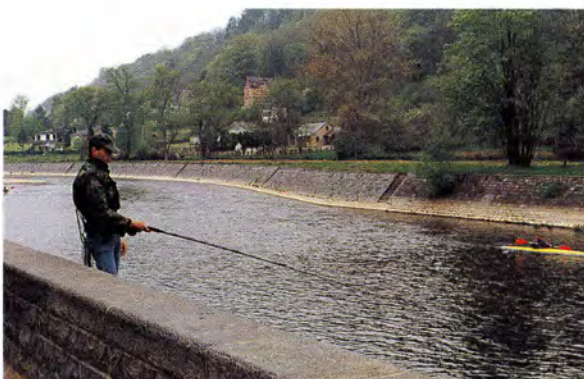
Un perré maçonné au moyen de moellons et de tablettes en calcaire petit granit
