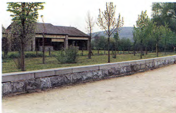
Mur anticrue à Barvaux
