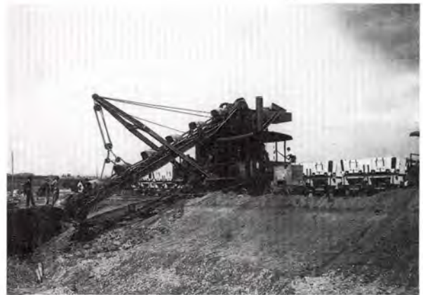
Vue d'une excavatrice à godet, pendant les travaux
