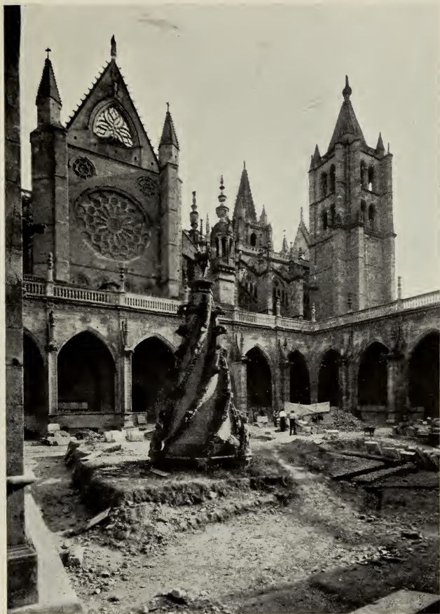
FACHADA NORTE. VISTA PARCIAL DESDE EL CLAUSTRO
