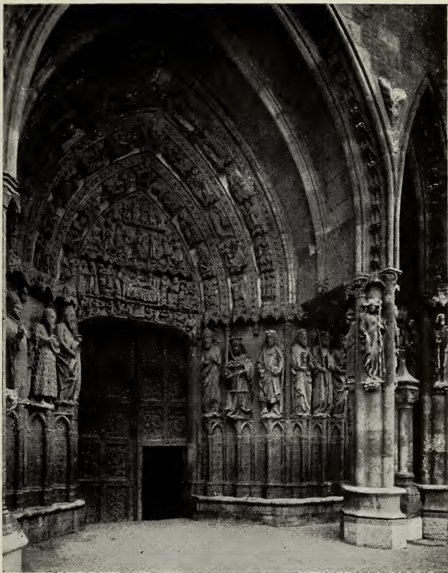
FACHADA PRINCIPAL. PUERTA LATERAL, LADO NORTE
