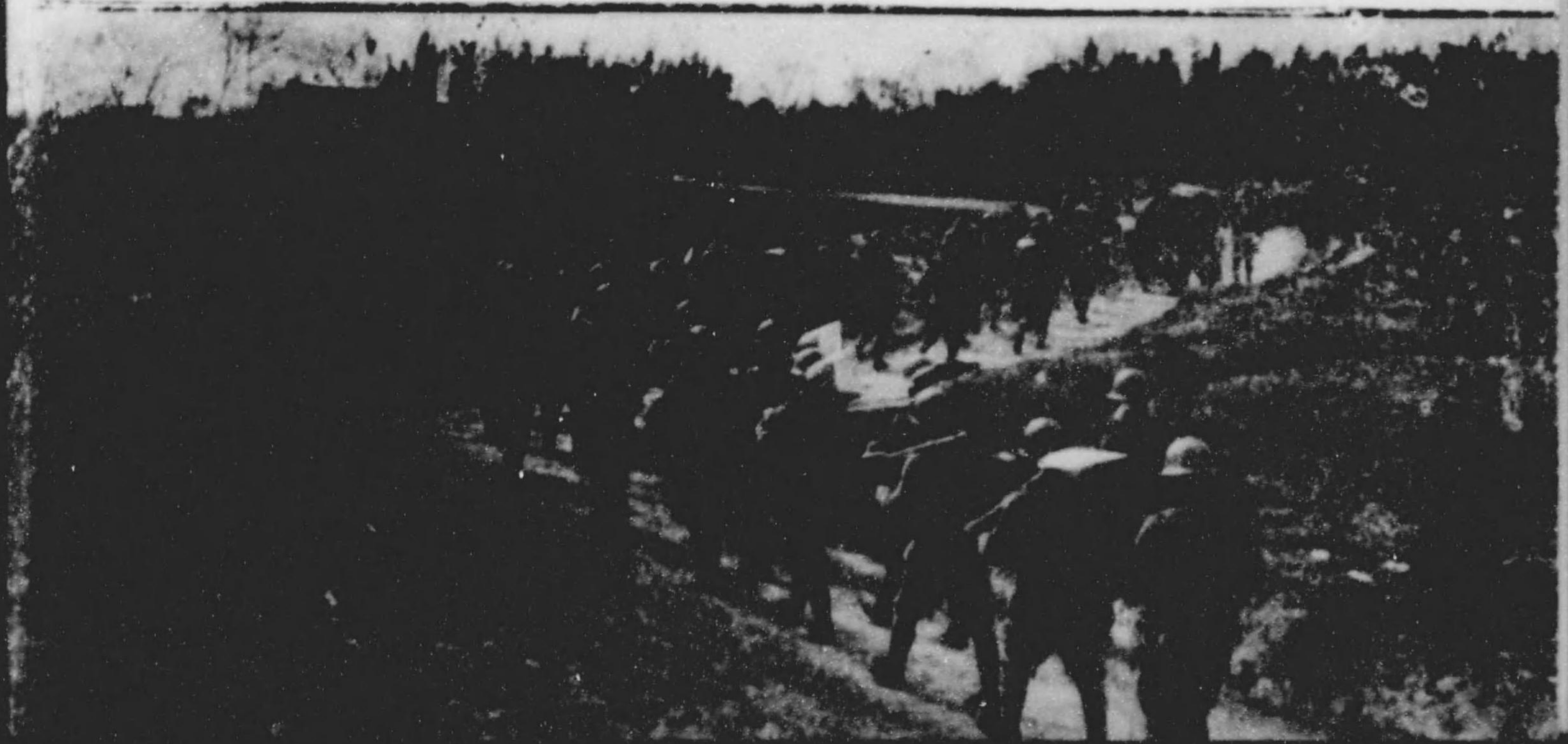
築城作業に出動する我が工兵隊(上海事變陣中撮影)
